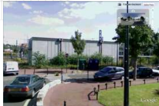
Photographie du poste de redressement de la RATP
