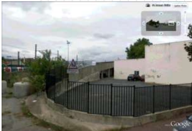
Vue sur la rampe d'accès à la toiture
