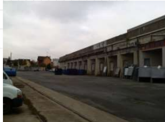
Vue depuis le parking sur les sas de chargement
