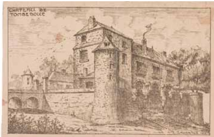
Château de Tombebouc Arch. dép. de Lot-et-Garonne, 7 Fi 6/1
