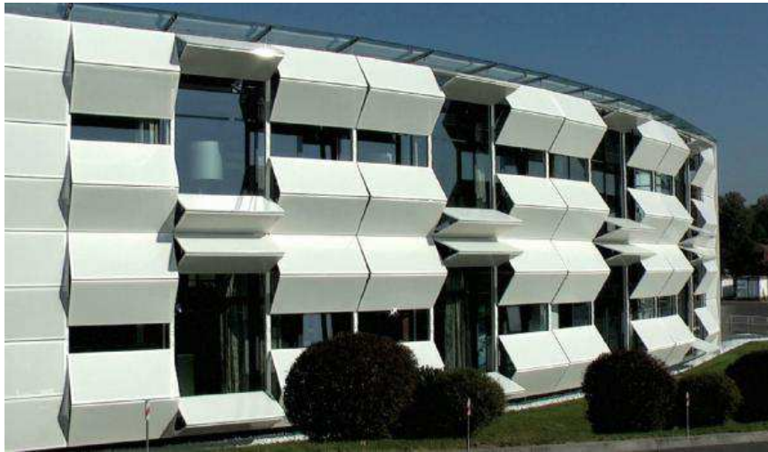
Abbildung 2.8: Die zehn Tonnen schwere Beschattungsanlage für die Nurglas-Fassade des Kiefer Technic Schauraums wurde mit dem Internationalen Architecture Award 2008 des amerikanischen Museums für Design und Architektur ausgezeichnet. (Bildquelle: http://www.worldarchitecture.org/world-buildings/world-buildings-detail.asp?position=detail&no=1757 )
