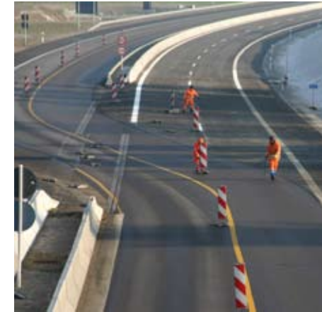
2. Der Verkehr wird angehalten. Die Beschäftigten der Autobahnmeisterei verschieben die roten Absperrbaken.
