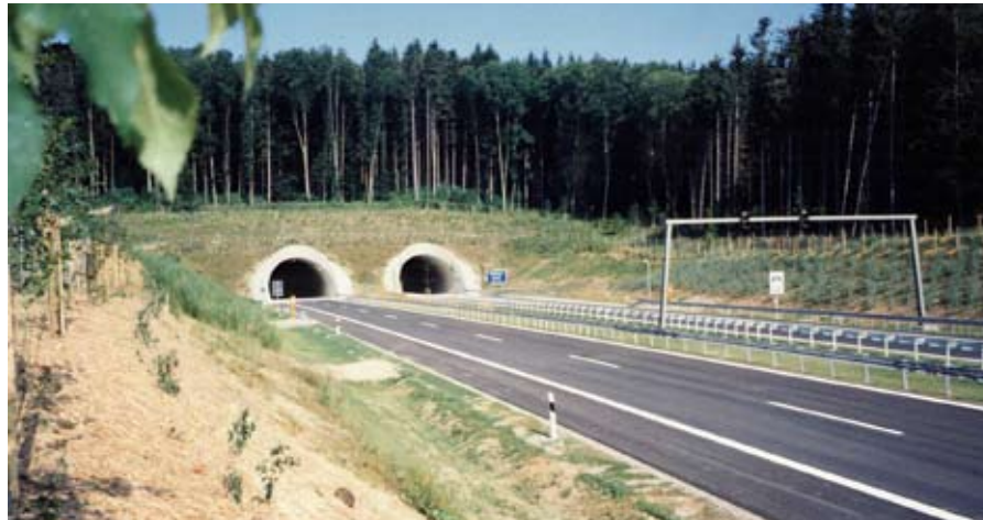
Kohlbergtunnel westlich von Mindelheim
