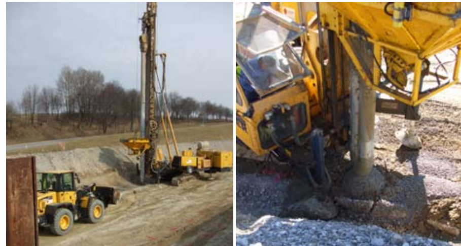
Spezialtiefbaumaßnahme: Rüttelstopfsäulen aus Schotter mit Zementsuspension
