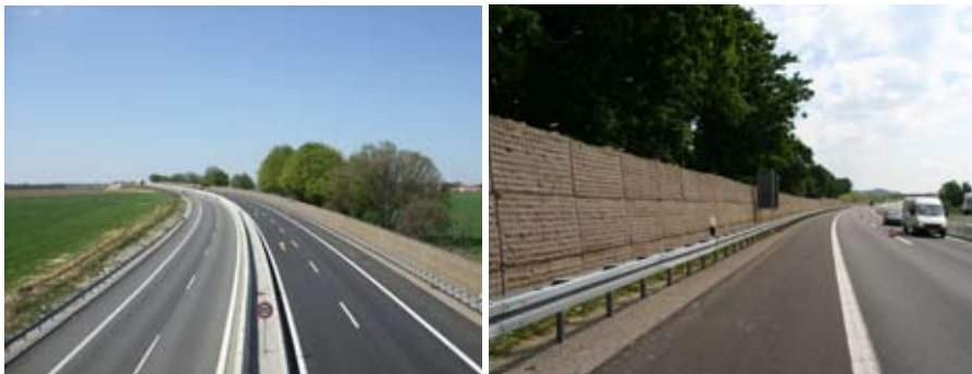
Bewuchsschützender Steilwall im Bereich Holzgünz
