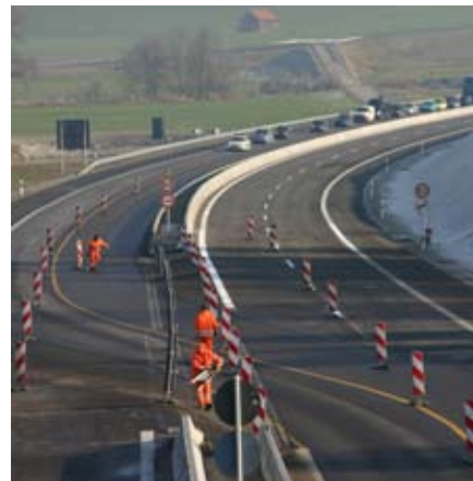
3. Die Lücke zwischen den Betongleitwänden im Mittelstreifen wird provisorisch abgesperrt - Im Hintergrund nähern sich die ersten Fahrzeuge.
