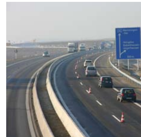
4. Auch aus der Gegenrichtung kommt der Verkehr - Im Folgenden wird die Markierung ergänzt und der Verkehr auf zwei Fahrstreifen pro Richtung freigegeben.
