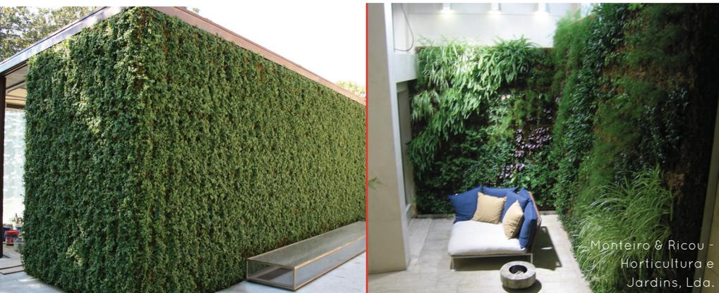
Nos jardins verticais modernos as plantas são mantidas sem solo, nutridas por meio de soluções hidropónicas, com ou sem substrato para fixação de raízes. Embora existam várias opções de construção a instalação de um jardim vertical, em edifícios de grande volume deve estar prevista no projecto inicial, como nas “natura towers”, que receberam a distinção de melhor edifício europeu do ano de 2011, construídas em Lisboa pela MSF – Activos Imobiliários,
