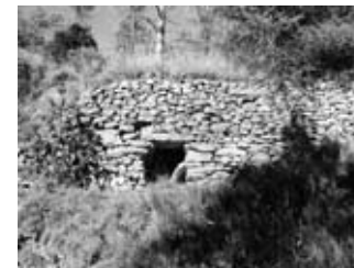
Marges de pedra seca a Coaner (Bages)
