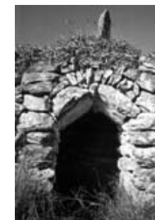
Fig. 4: Portal d'angle amb arc de descàrrega
