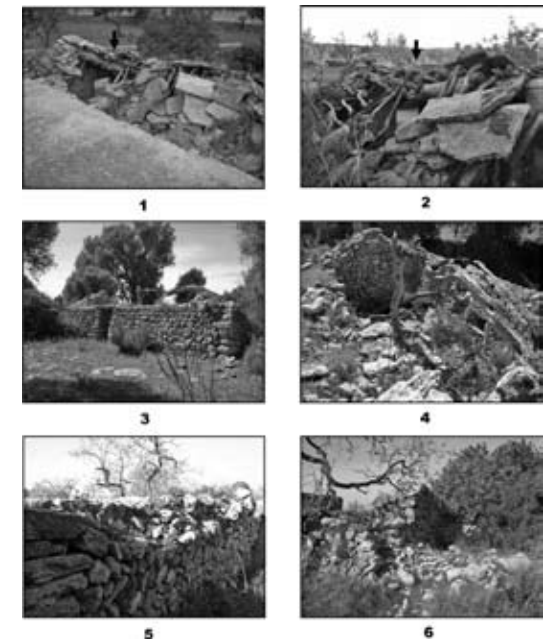
Figura 2: 1 i 2.- Estadi 6: Barraca de Can Puig. 3 i 4.- Estadi 8: Barraca de Can Xim. 5.- Estadi 9: Barraca II de Can Puig. 6.- Estadi 11 i 12: Barraca III de Can Puig.
