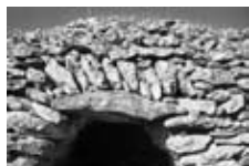
Fig. 1: Llanda suficient amb arc de descàrrega
