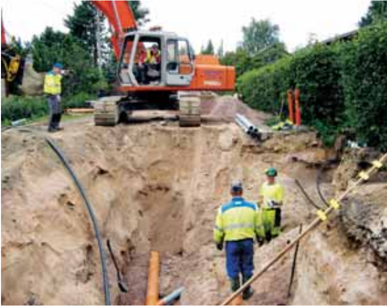
Verkstorakennustyömaa Porissa Kapraantiellä.
