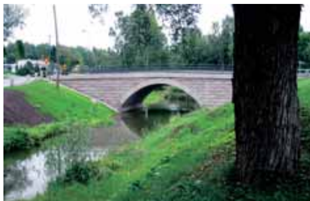
Kannusilta on Taivassalon punagraniittia, holvin ja reunapalkkien pinta poltettua ja muurien lohkottua graniittia.
