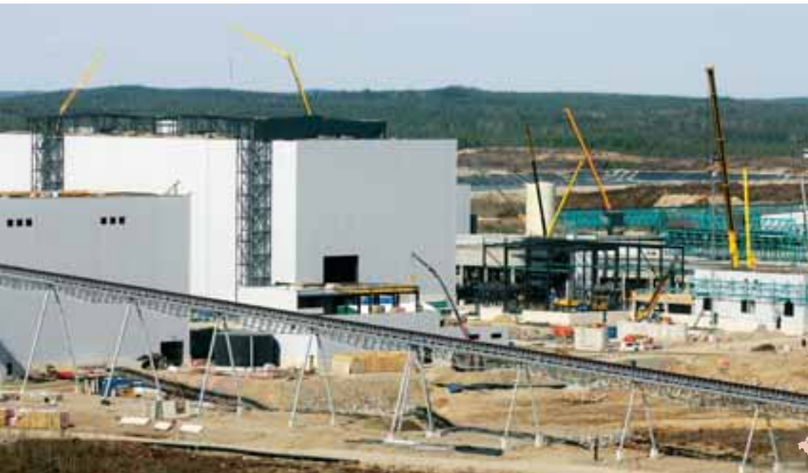
Kaivoksen asemakaava-alueelle on noussut mittava tehdasalue kymmenine rakennuksineen. Tärkein kokonaisuus on metallien talteenottolaitos, jossa biokasaliuotuksen myötä saadusta nesteestä erotetaan arvokkaat malmit.
