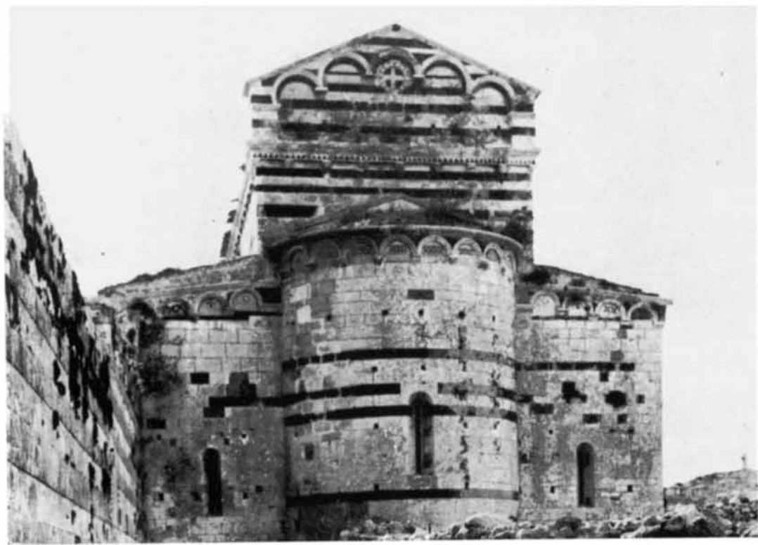
BORUTTA - CHIESA DI S. PIETRO DI SORRES: TRIBUNA (PRIMA DEL RESTAURO)
