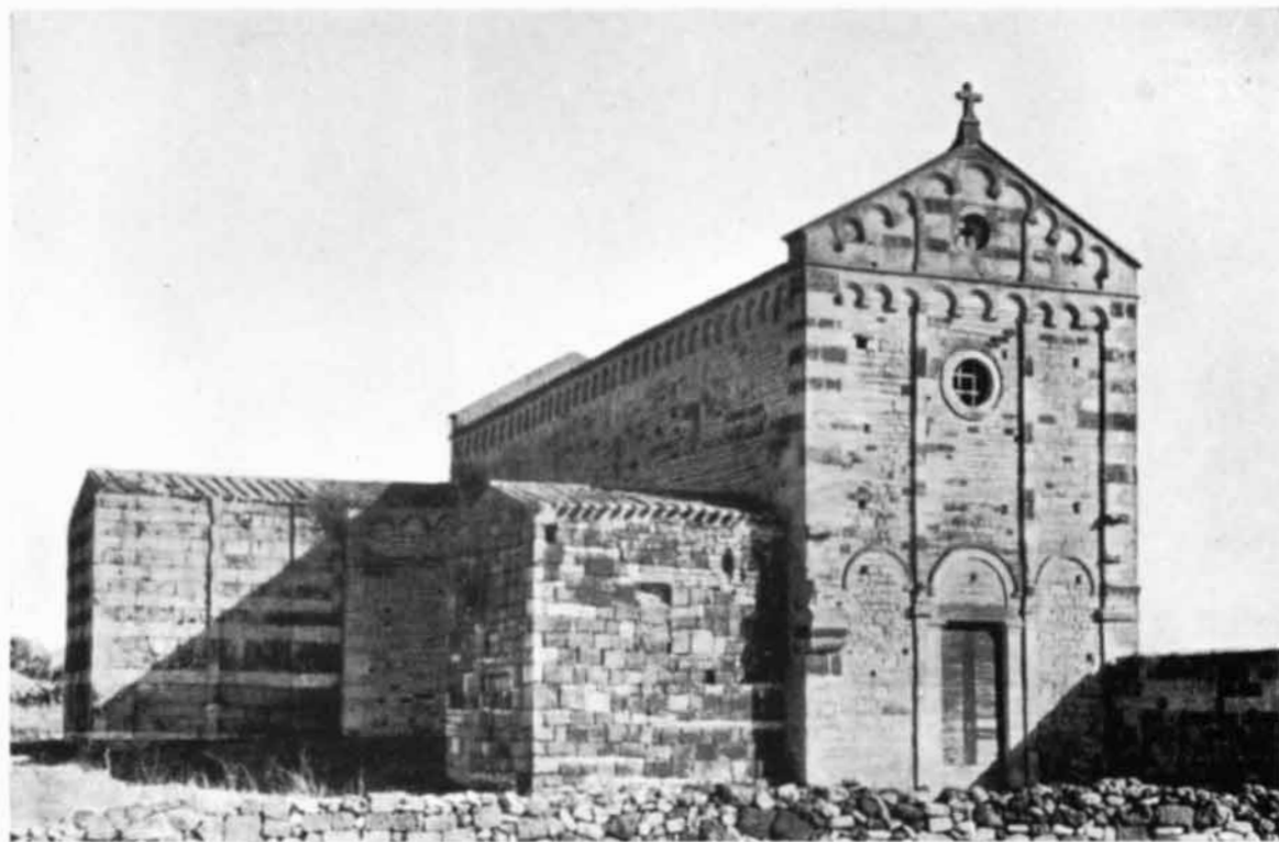
PLOAGHE — CHIESA DI S. MICHELE DI SALVENERO; PROSPETTO E FIANCO (DOPO IL RESTAURO)
