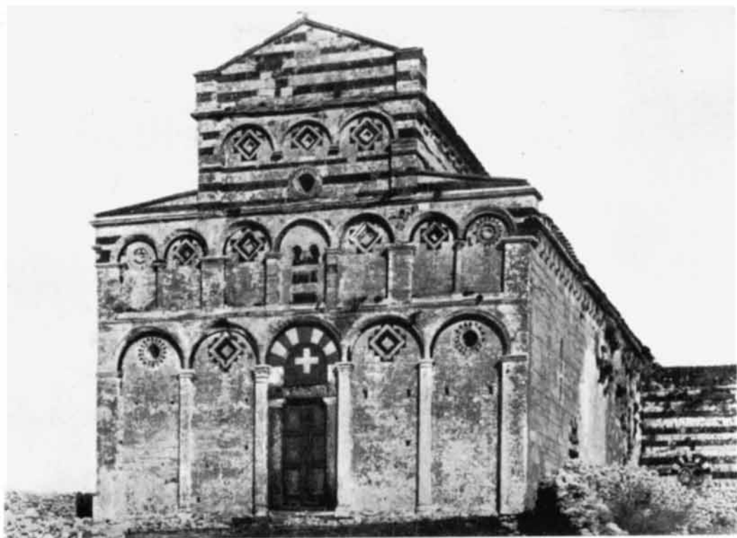
BORUTTA - CHIESA DI S. PIETRO DI SORRES: PROSPETTO (PRIMA DEL RESTAURO)
