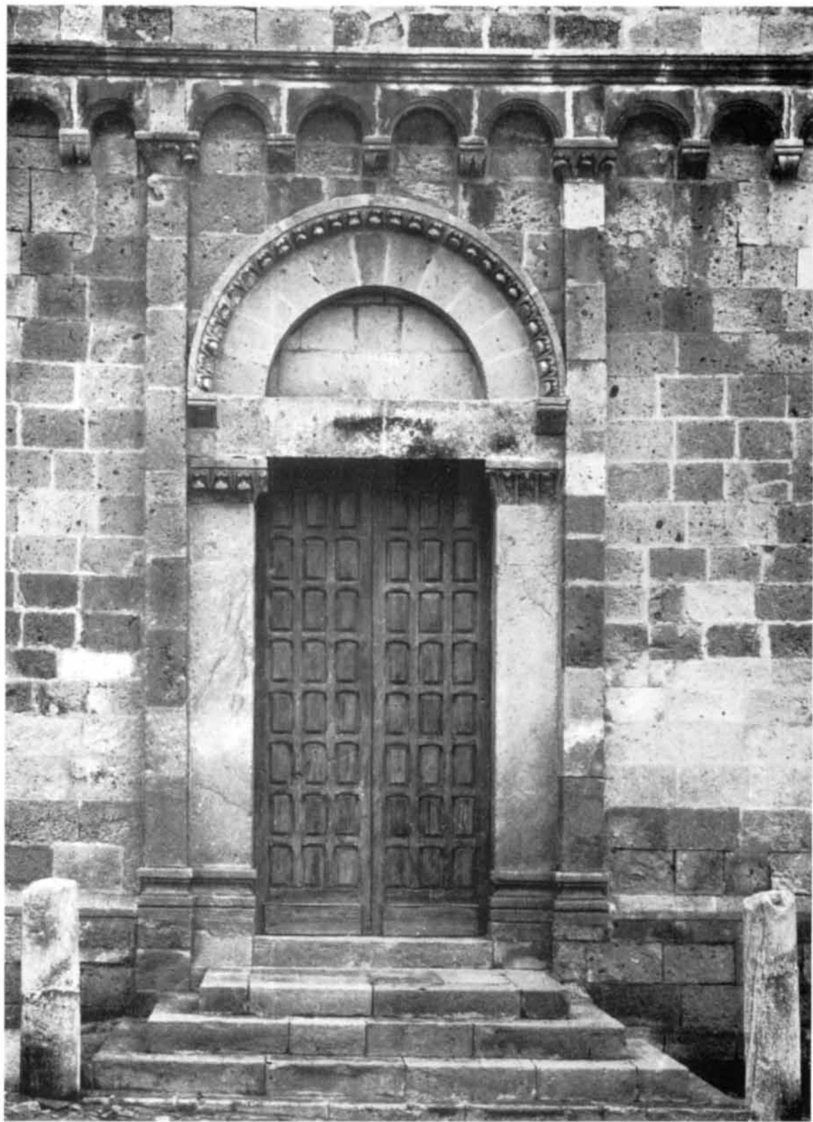
TRATALIAS — CHIESA DI SANTA MARIA: PORTALE DEL PROSPETTO
