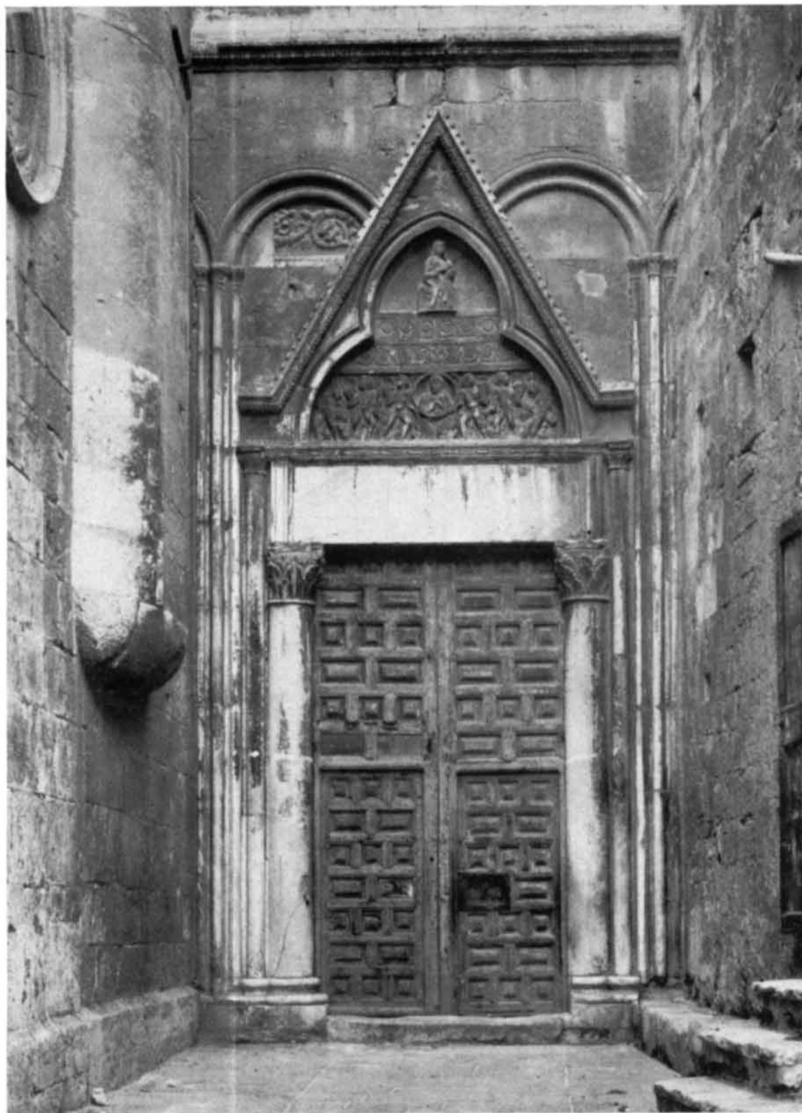
CAGLIARI – CHIESA DI S. MARIA DI CASTELLO: PORTALE DEL BRACCIO SUD DEL TRANSETTO
