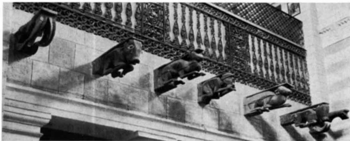
ORISTANO — CHIESA DI S. CHIARA: MENSOLE DELLE ANTICHE CAPRIATE
