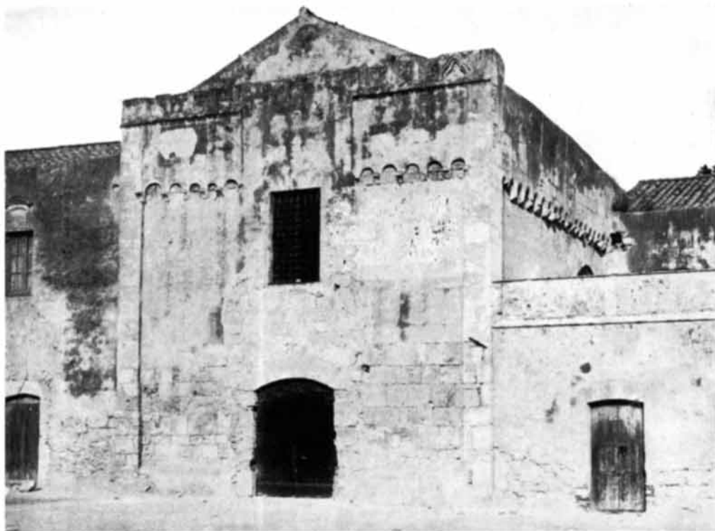
CAGLIARI — CHIESA DISTRUTTA DI S. MARIA DEL PORTO: PROSPETTO
