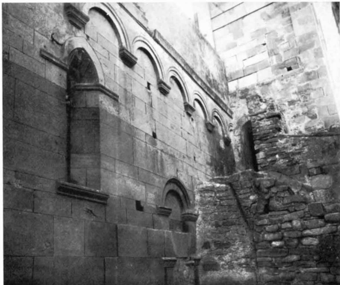
SUELLI - CHIESA DI S. GIORGIO: FIANCO SETTENTRIONALE
