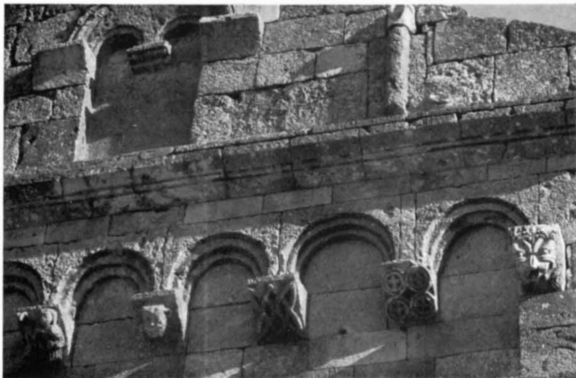
UTA — CHIESA DI S. MARIA: ARCHEGGIATURE E MENSOLE DEL PROSPETTO
