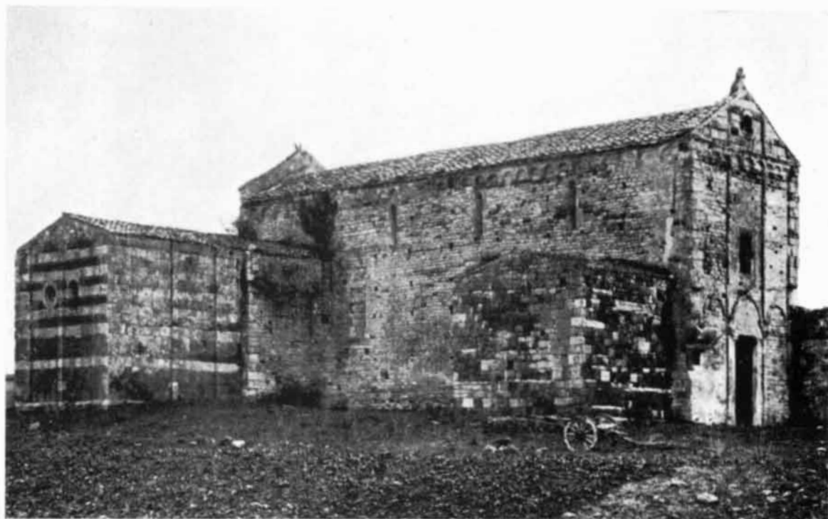
PLOAGHE — CHIESA DI S. MICHELE DI SALVENERO; PROSPETTO E FIANCO (PRIMA DEL RESTAURO)
