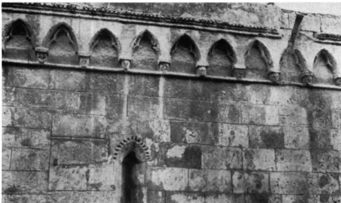
SASSARI — CHIESA DI S. DONATO: ARCHEGGIATURE DEL FIANCO SETTENTRIONALE
