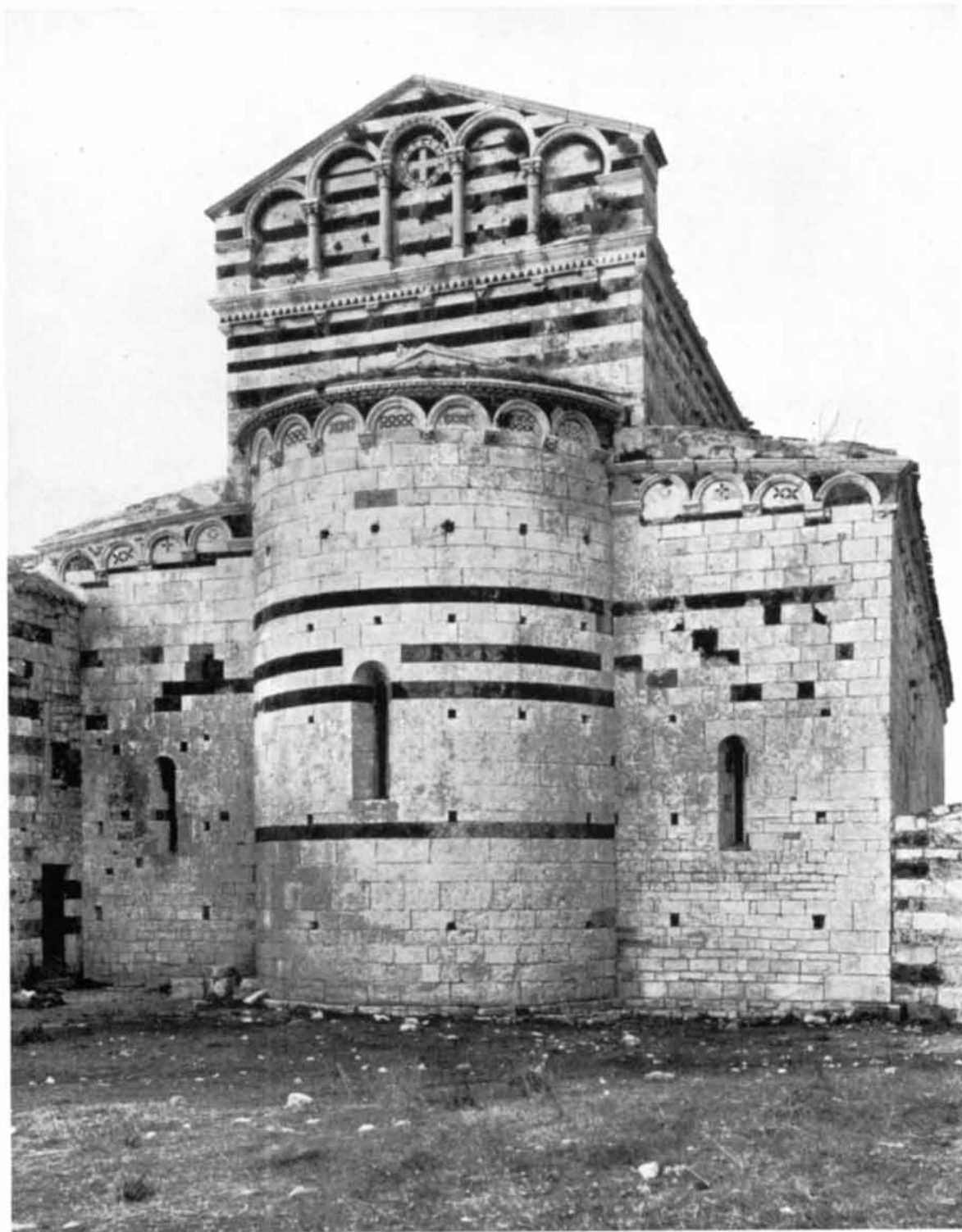
BORUTTA - CHIESA DI S. PIETRO DI SORRES: TRIBUNA (DOPO IL RESTAURO)
