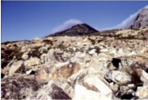
Charca formada en el desprendimiento
