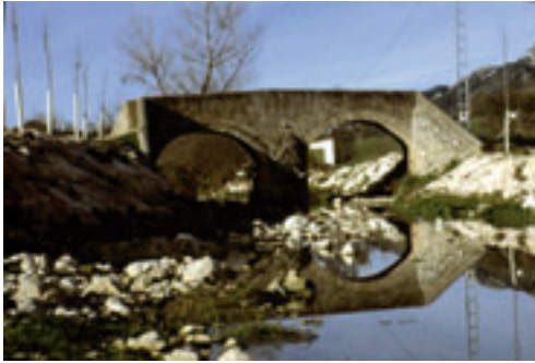
Puente medieval sobre el Río Sabar
