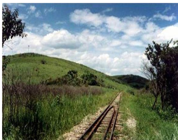
FOTOGRAFIA 05 – linha férrea cortando a RB
