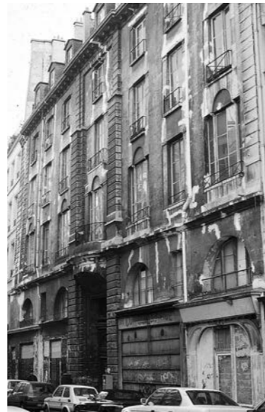
Etat de la façade en 1998.
