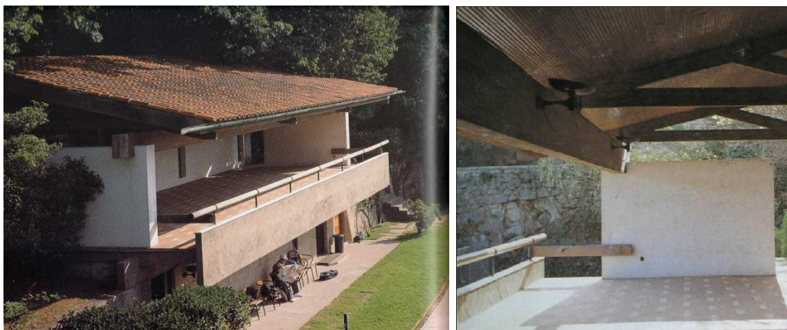
Fig.3 e 4: Pavilhão de Tênis/Quinta da Conceição (Fotos: s.n. e Rui de Sousa)
