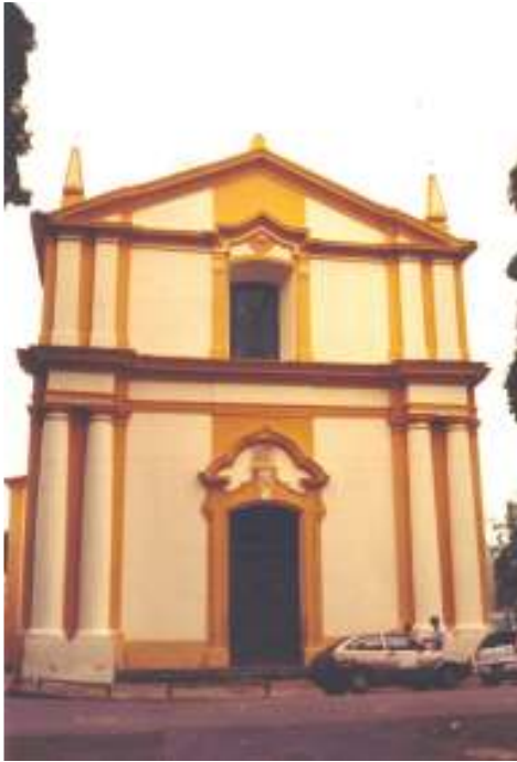
Figura 9: Fachada da igreja de São João com colunas duplas e molduras do tardo-barroco
