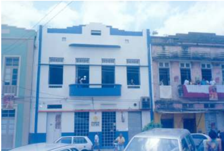
Figura 59: Casa de D. Zoraide e Sr. Aprígio, com a fachada em estilo Art Decò conforme reforma feita pelo pai dela em 1946 Fonte: MIRANDA, Cybelle. 2003
