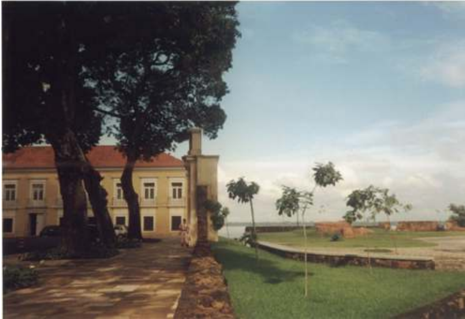
Figura 95: Visão atual do espaço, sem o muro, abrindo a visão para o rio Fonte: MIRANDA, Cybelle, 2004
