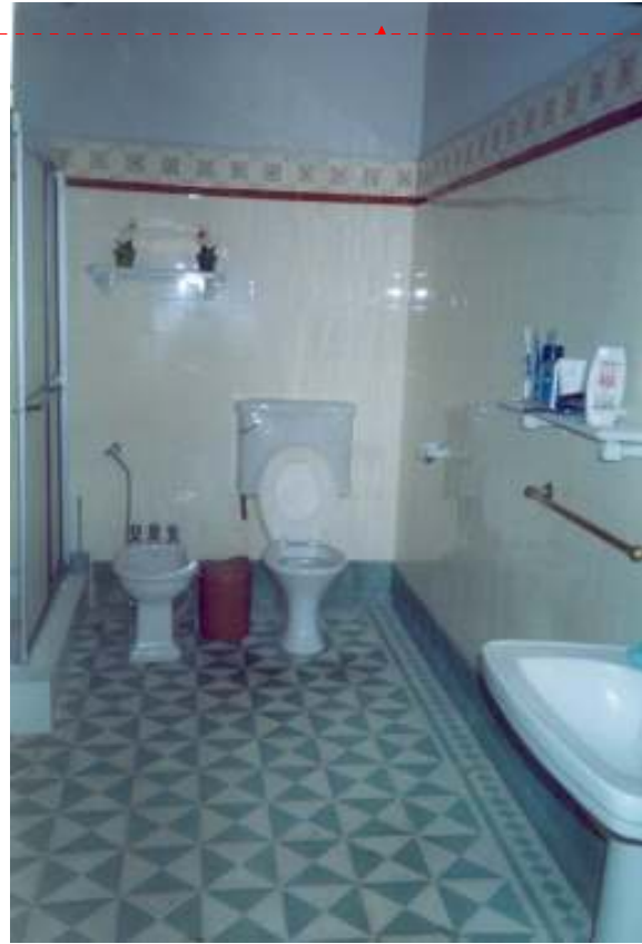
Figura 52: A ampla 'sala de banho' com piso em ladrilho Hidráulico na casa de Ana Lúcia Fonte: MIRANDA, Cybelle, 2004
