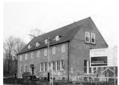
Das frühere Arbeitsamt vor dem Abriss (1998)
