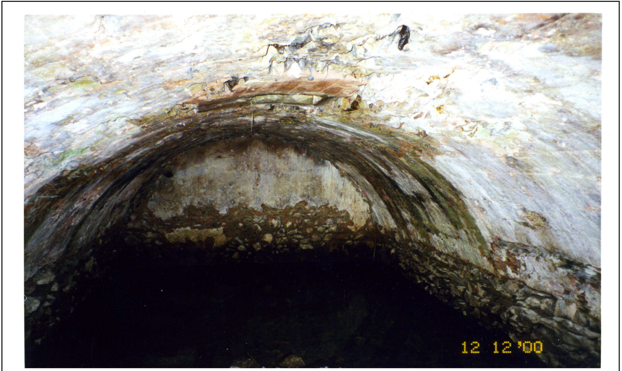
Figura 1: Cisterna principal del castell de Llívia. Aquesta és una estructura excavada a la roca i coberta per una volta d'obra que permetia assegurar la provisió d'aquest preuat element als defensors del castell. Alhora, la torre de l'homenatge gaudia de la seva pròpia cisterna, d'idèntiques característiques però menor dimensió.
