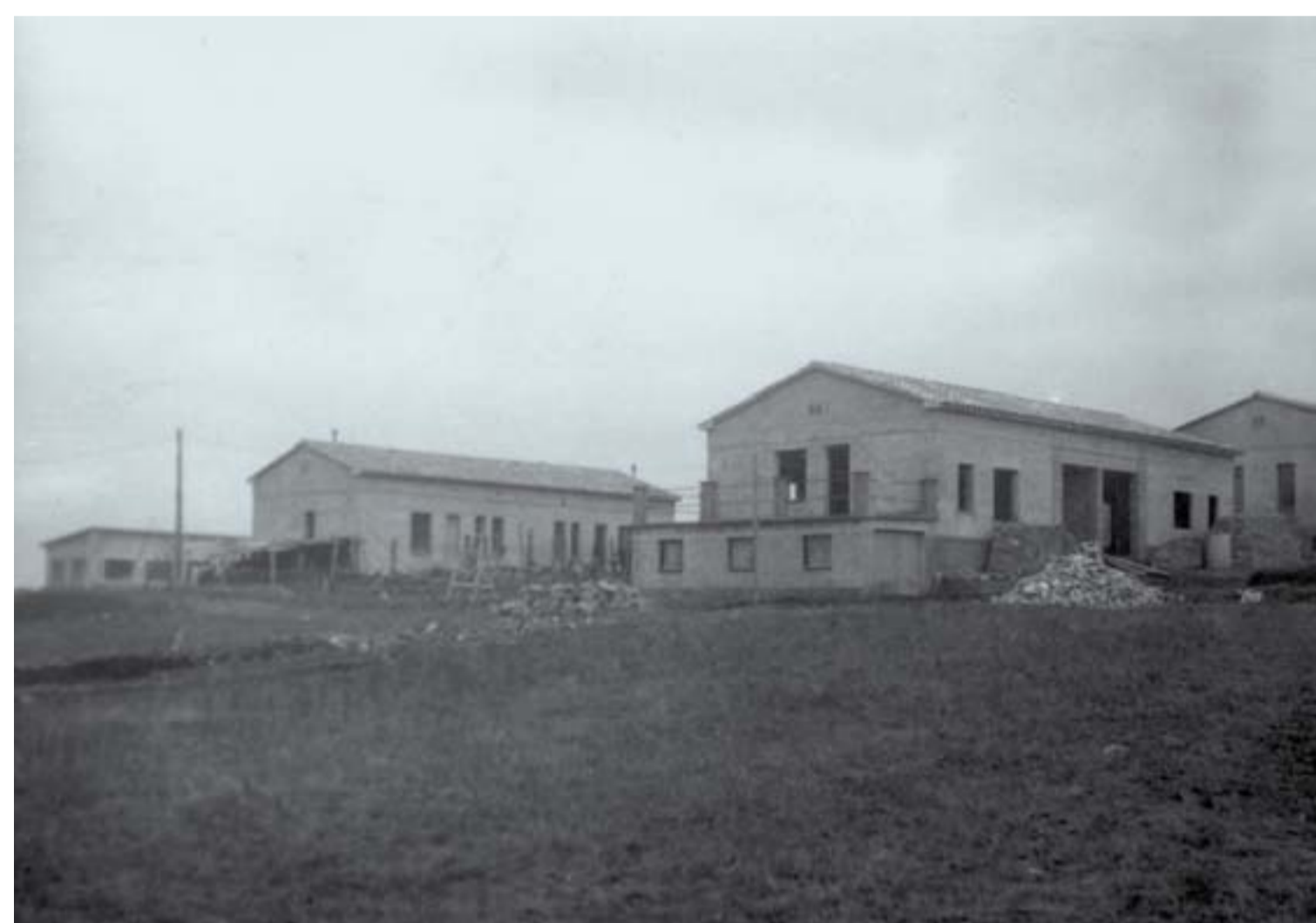
Cases en construcció
