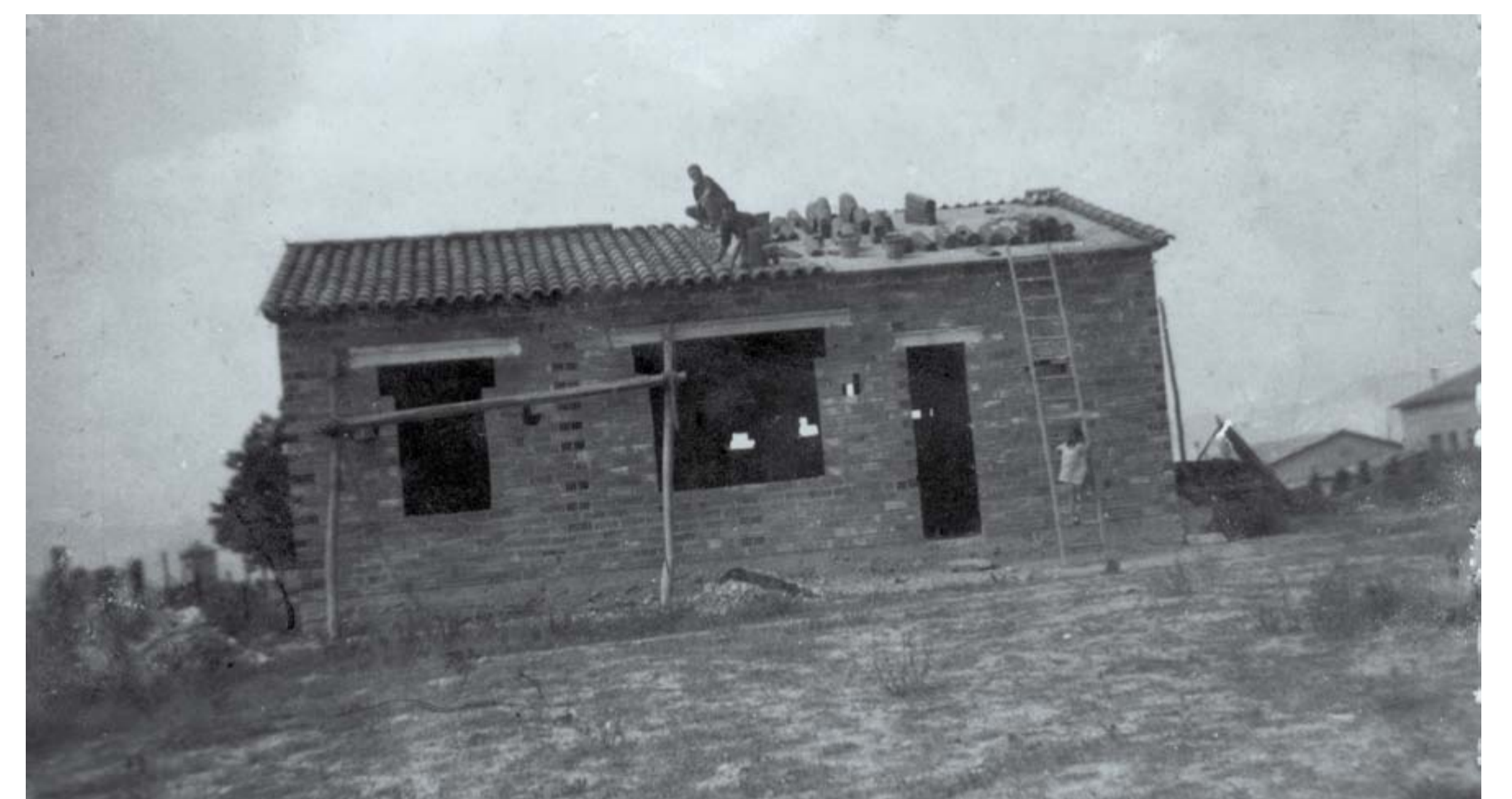
Construint la teulada de la casa
