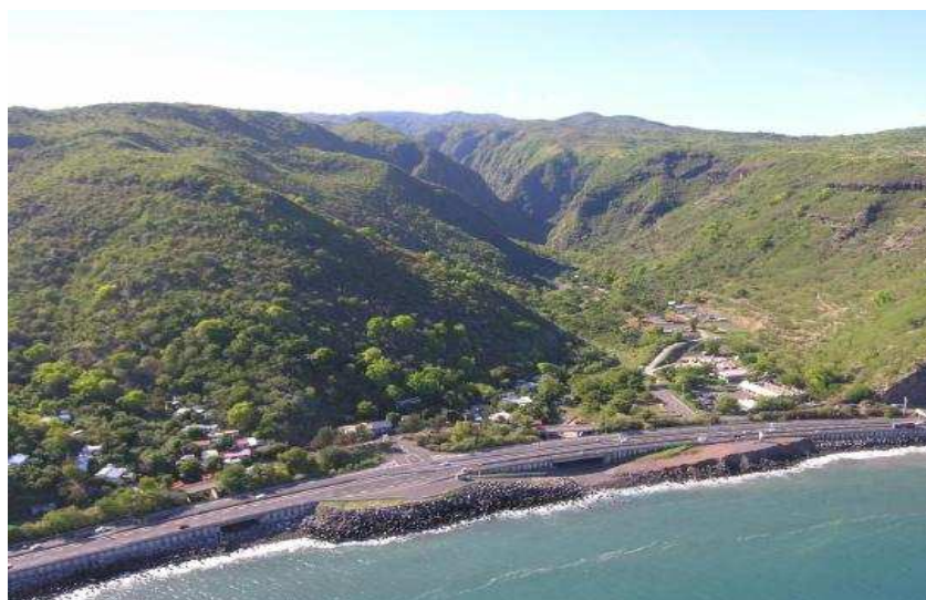
Photographie (situation actuelle) du site de La Grande Chaloupe
