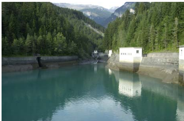
Photo 5. Bassin de compensation de l'usine de Croix
