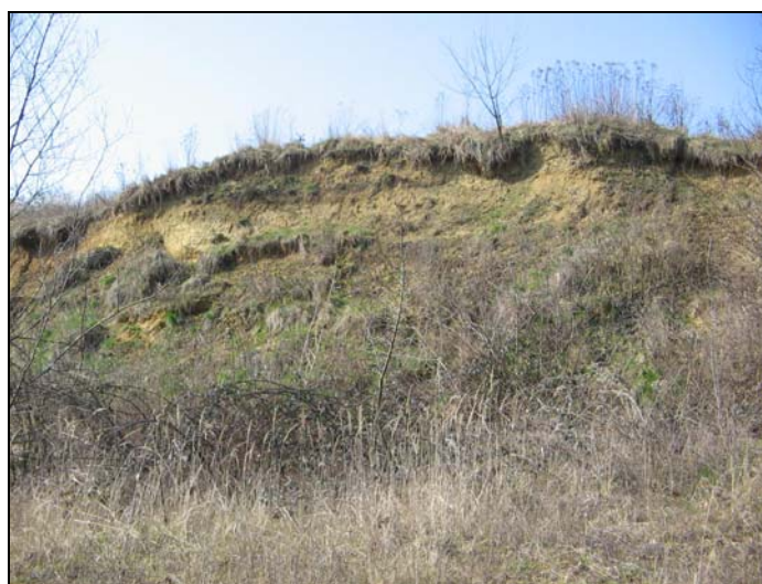
Slika 10: Zahodno od regionalne ceste Pečarovci–Šalamenci je pri zaselku Severjeva Graba nastal plaz z od 2 do 4 m visokim in 25 m dolgim odlomnim robom. (Foto: R. Vidak).
