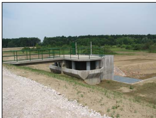
Slika 17: Zadrževalnik na Kobiljskem potoku na dan tehničnega pregleda. (Foto: J. Novak)
