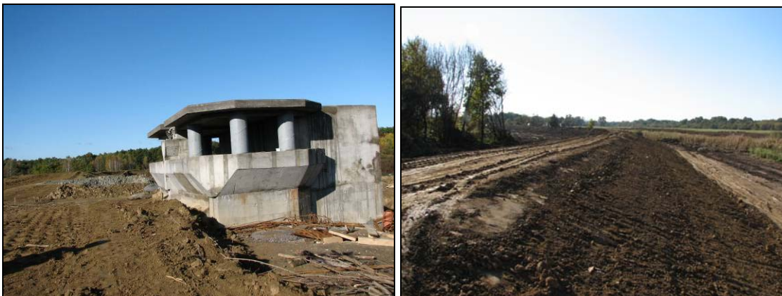
Slika 15, 16: Zadrževalnik na Kobiljskem potoku v gradnji v mesecu novembru 2007. (Foto: J. Novak)
