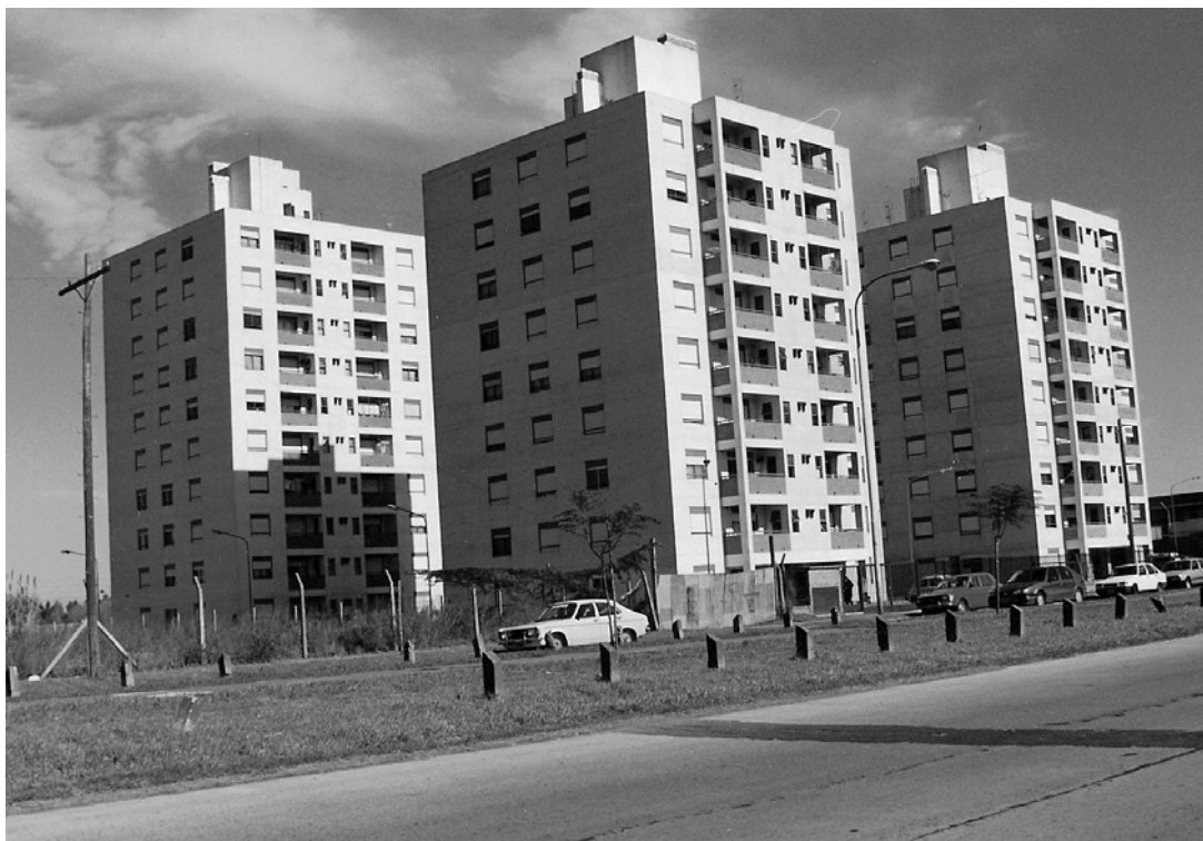
Figura 29: 1997, Edificio Cooperativa Personal Subterráneos II (FONAVI Cofinanciado - CMV) 70 viviendas.
