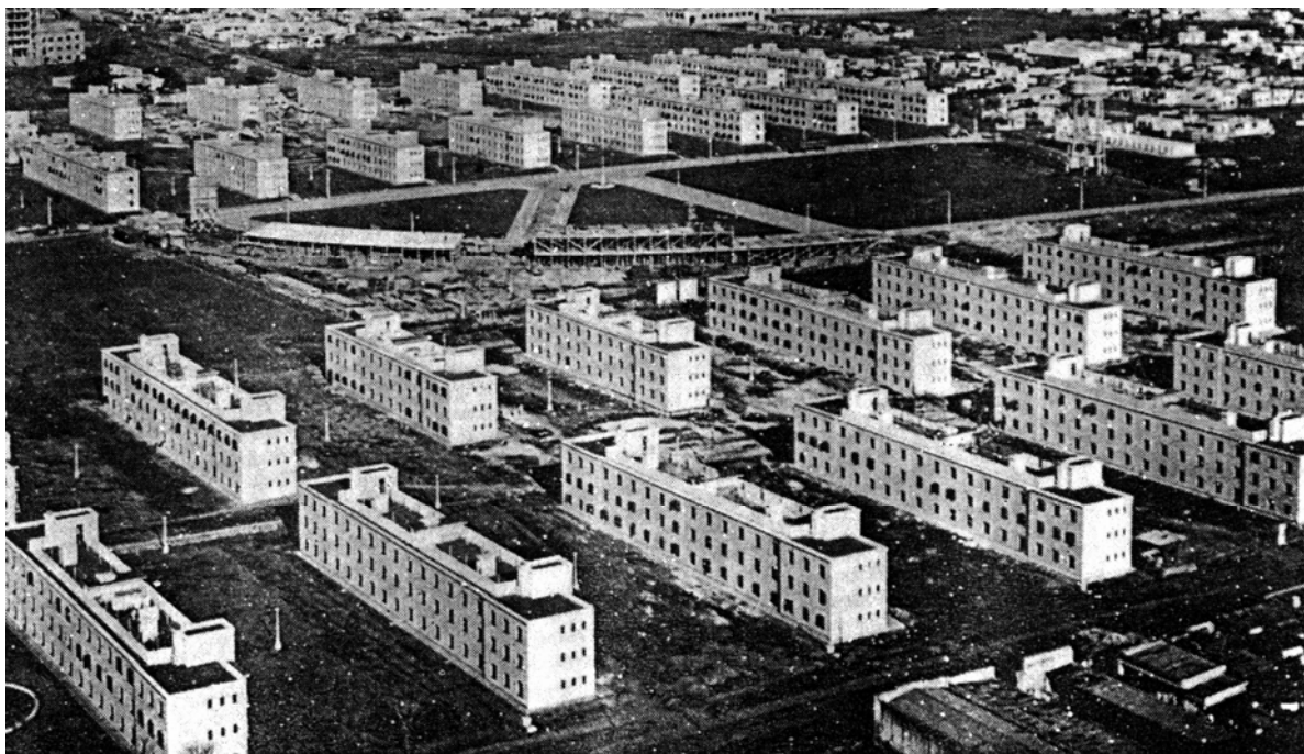
Figura 12-13: 1949, Barrio Manuel Dorrego ("Los Perales") (Plan Eva Perón-MCBA) 1068 viviendas/ Planta de conjunto y vista general del barrio en construcción.
