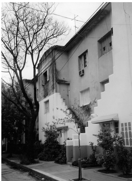
Figura 6: 1937, Casa Colectiva Alvear II (CNCB) 128 viviendas, Arq. Pirovano.
