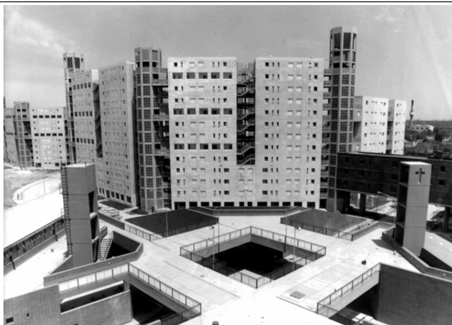
Figura 21-22: 1974 -1981, Conjunto Urbano Cmte. Piedrabuena (Plan Alborada), 2100 viviendas. Estudio Manteola y otros. Axonometría del conjunto y vista general del barrio en construcción.
