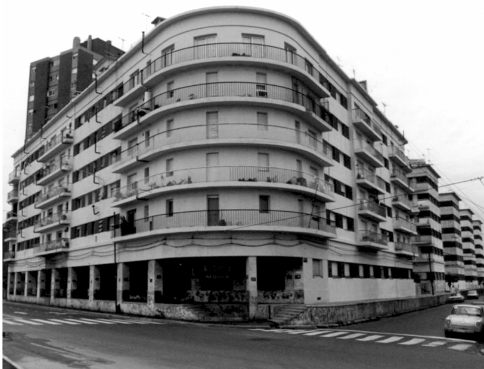
Figura 7: 1943, Casa Colectiva Martín Rodríguez, (CNCB) 141 viviendas.
