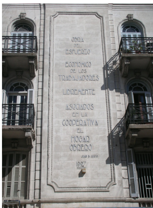
Figura 10: 1927, Edificio Angel Giménez (2da. Casa Colectiva.de EHO), Juan D. Perón 2070/8; 24 viviendas; Ings. Velazco y Justo.
