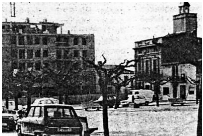
Una imatge de l'antiga Plaça Catalunya abans de les obres
