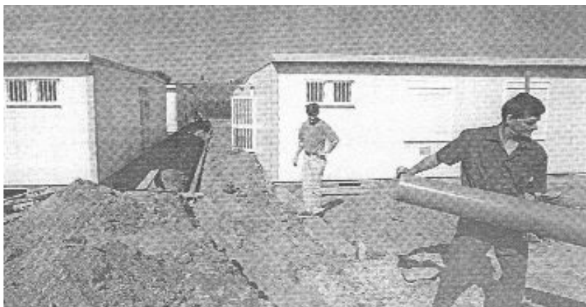
Les obres d'instal·lació de les aules prefabricades de l'IES provisional.
