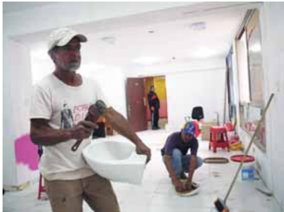
Trabajadores realizan trabajos de adecuación en el espacio. FOTOS LUIS BOBADILLA
