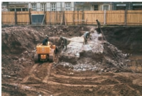
Abbruch der Fundamente der ältesten Neustädter Kirche 1965.
