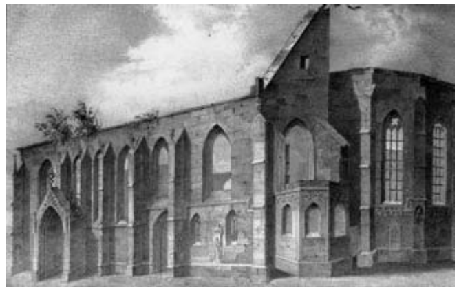
Nach dem Stadtbrand von 1826 blieb die Neustädter Kirche lange als Ruine stehen.
