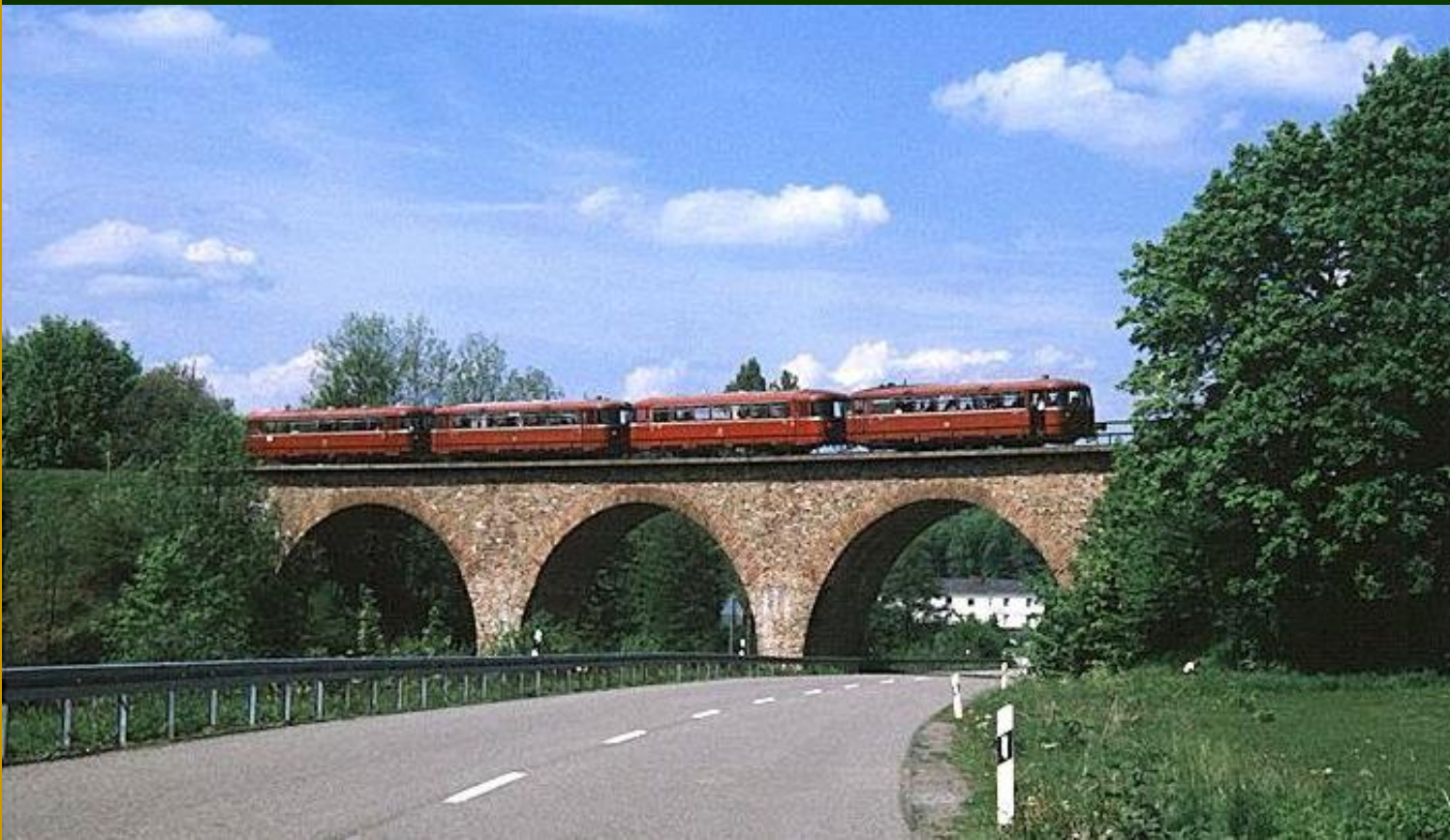
Schienenbus Auf dem Nonnweiler Viadukt
