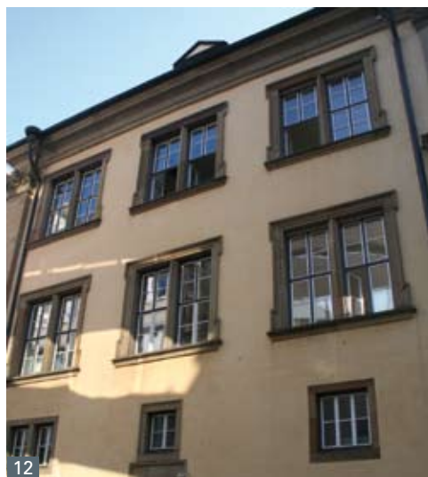
Abb. 14 Tübingen; Uhlandstraße, Keppler – Gymnasium: neu Verbund- fenster um 1970. Die Grobbin- nengliederung wurde übernom- men, auf eine Sprossierung wurde verzichtet.
