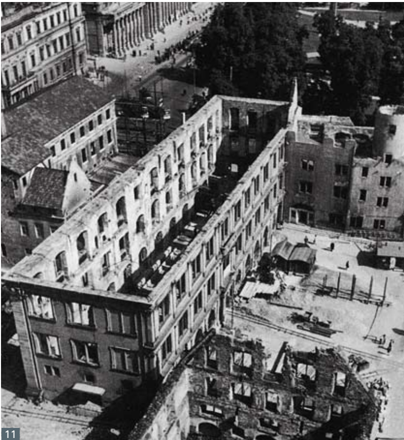
Abb. 11 Stuttgart, Schillerplatz 4 Prinzenbau: Das Gebäude brannte nach einem Fliegerangriff in der Nacht vom 12. auf den 13. Septem- ber 1944 fast vollständig aus.
