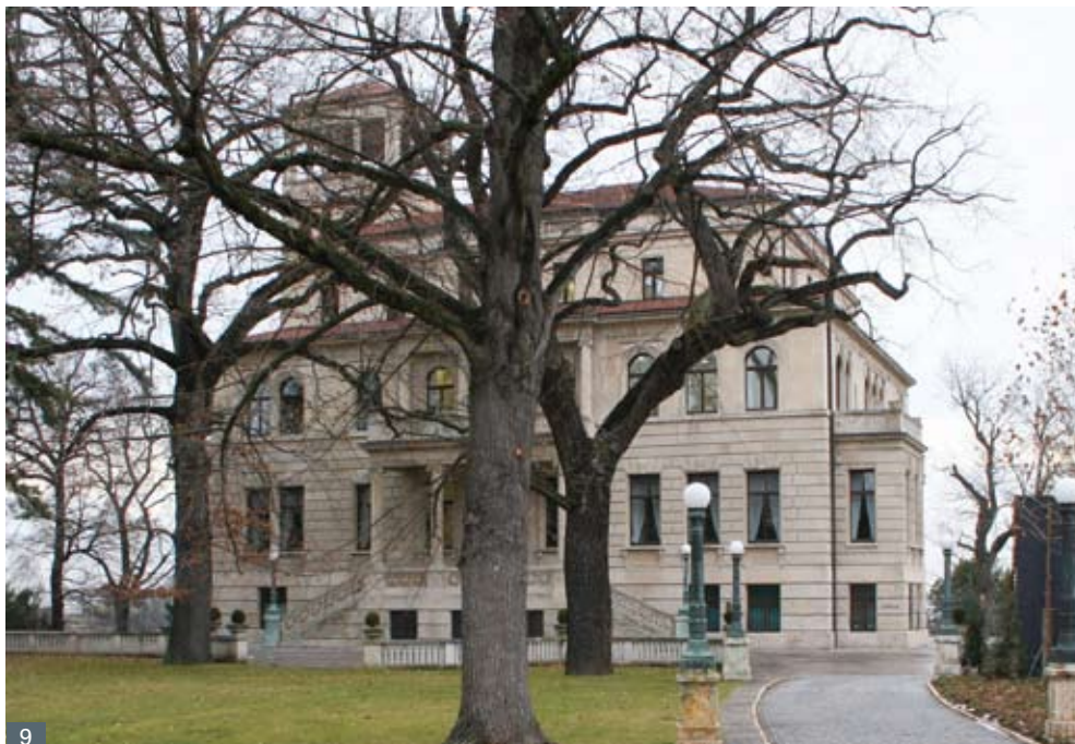
Abb. 9 Stuttgart, Heidehofstraße 31; Villa Bosch; Dokumentation bauzeitliche Verbundfenster.
