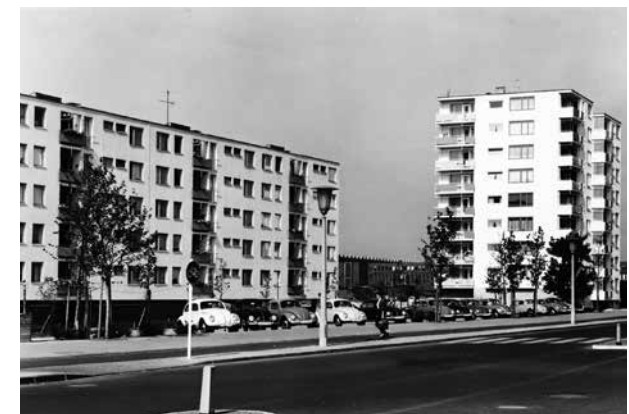
Lessingstraße, 1959. Blick auf den östlichen Rand der Wohnsiedlung mit dem Punkthochhaus im Hintergrund. Foto: Institut für Zeitgeschichte und Stadtpräsentation (IZS).
