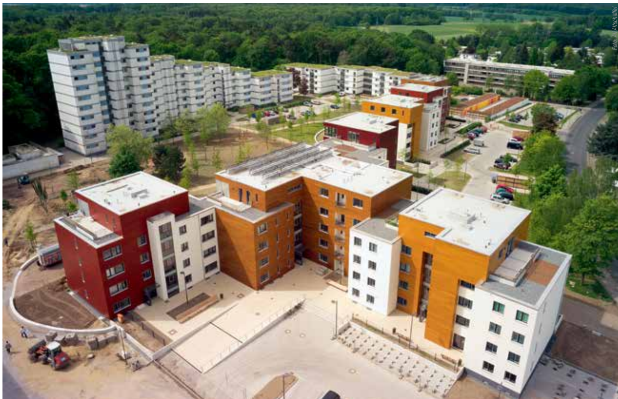
Aktuelle Dachansicht der „Neuen Burg“, 2011. Über dem viergeschossigen Altbau entstanden neue Penthousewohnungen mit Dachterrassen.
