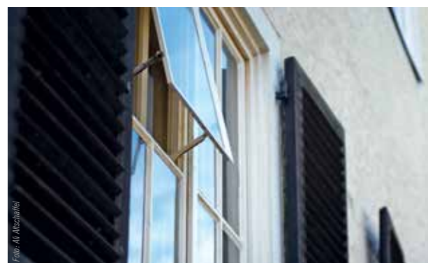
Hölzerne Doppelkastenfenster sorgen für eine gute Wärmeisolierung. In den Küchen und Bädern sind sie mit Lüftungsflügeln ausgeführt.
