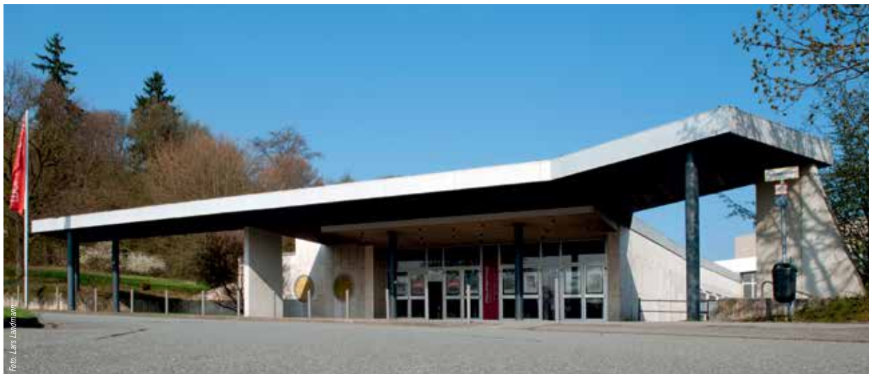
Eingangsansicht mit dem großen, frei geformten Dach, das weit über die Wände des Foyers hinaus ragt
