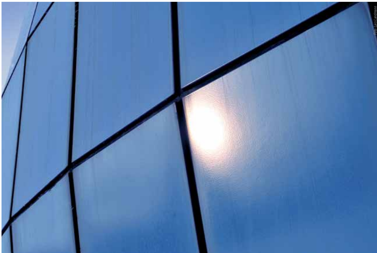
Blau emaillierte Bleche als Verkleidung der Betonschale
