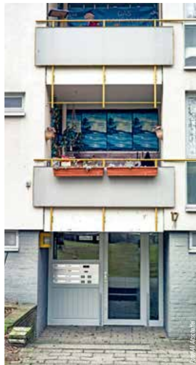
Loggien an beiden Seiten umschließen die innen liegenden Treppenhäuser, die nur indirekt belichtet sind.
