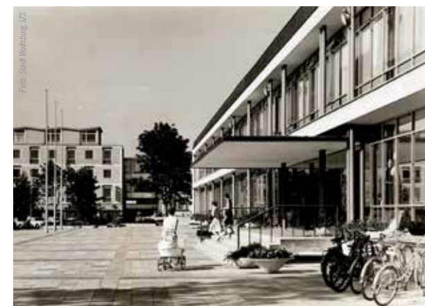
Der Eingang des Rathauses, um 1960. Das extrem dünn ausgeführte Vordach scheint fast über dem Haupteingang zu schweben.
