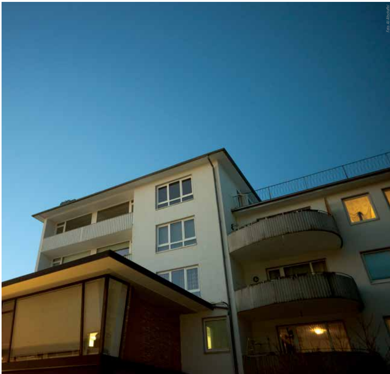
Die geschwungenen Balkone des rückwärtigen Wohnhauses entsprechen dem Geschmack der Zeit. Der große Dachüberstand ist typisch für die frühen Flachdächer, die noch nach außen entwässert wurden.
