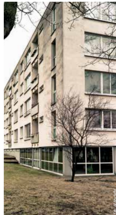
Ehemaliger Gemeinschaftsraum im Erdgeschoss. Das natürliche Gefälle des Geländes wurde ausgenutzt, um nach Süden einen zusätzlichen Raum aus der Sockel- und Kellerzone herauszuschieben.
