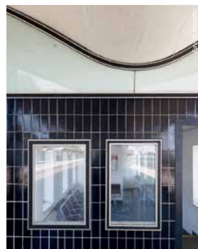
Fenster des Wartehäuschens am Bahnsteig. Typisch für die Nachkriegsmode sind die sorgfältig entwickelten Details und die hochwertigen Materialien.
