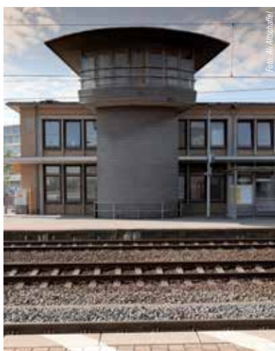
Die ehemaligen Räume des Fahrdienstleiters schieben sich aus dem Hauptgebäude heraus und ermöglichen den freien Blick auf die Bahnsteige
