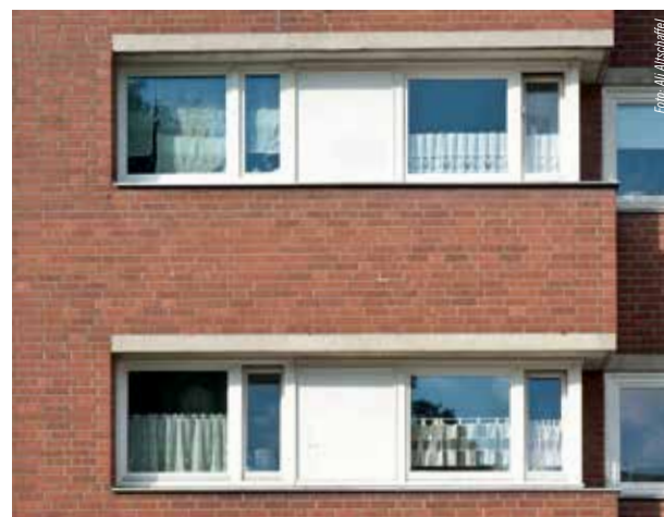
Fensterdetail. Typisch sind die offene Fensterecke und der sichtbare Betonsturz.
