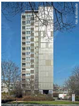
Ein quer liegender eingeschossiger Trakt schiebt sich unter das Hauptgebäude
