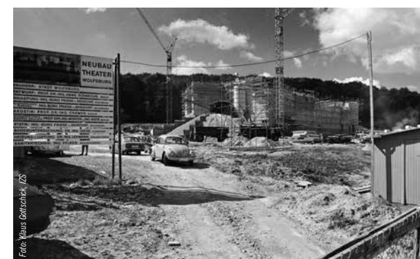
Das Zuschauer- und Bühnenhaus im Rohbau, 1971
