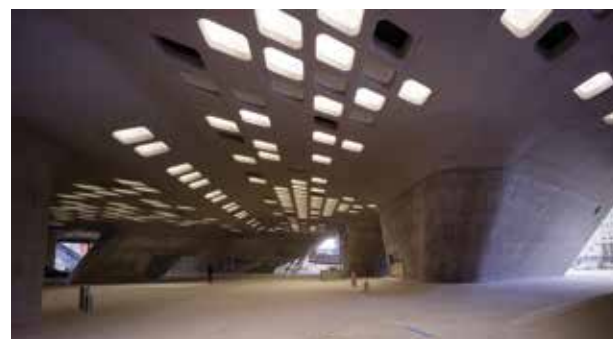
Eine Kassettendecke mit einer diagonal verlaufenden Balkenstruktur und rautenförmigen Zwischenräumen bildet die Untersicht
