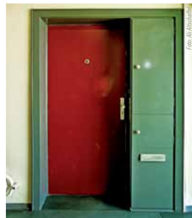
In der oberen Klappe der Wohnungstüren finden sich heute die Zähler, in der mittleren war das sogenannte Brotfach. Darunter war der Briefkasten der Wohnung.
