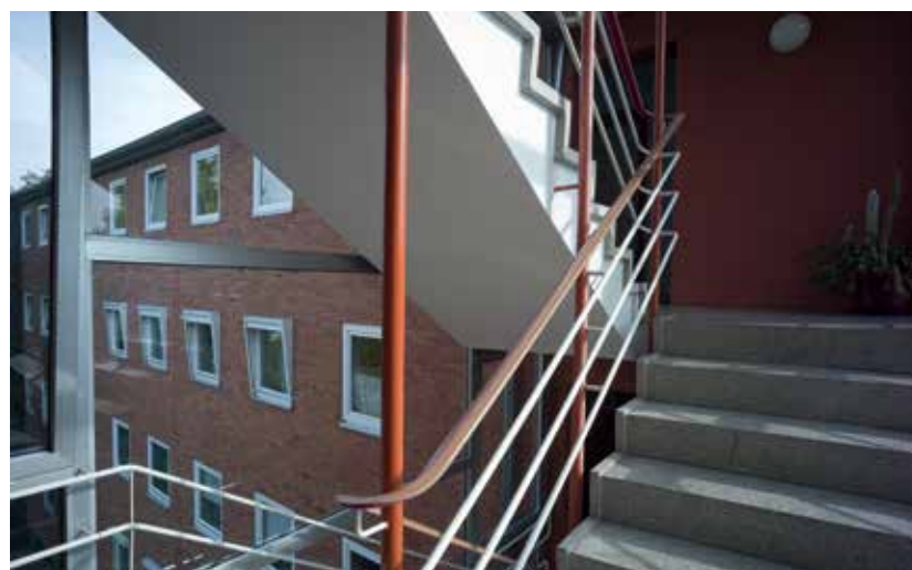
Blick aus dem Treppenhaus. Trotz Denkmalschutz sind viele der originalen Holzfenster bereits verschwunden
