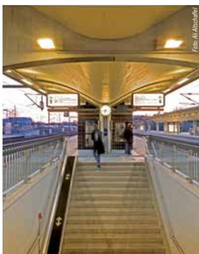
Aufgang zum Bahnsteig mit seinen geschwungenen Dächern. Die Unterseite der Betondächer ist bewusst strukturiert durch die Spuren der Holzschalung.
