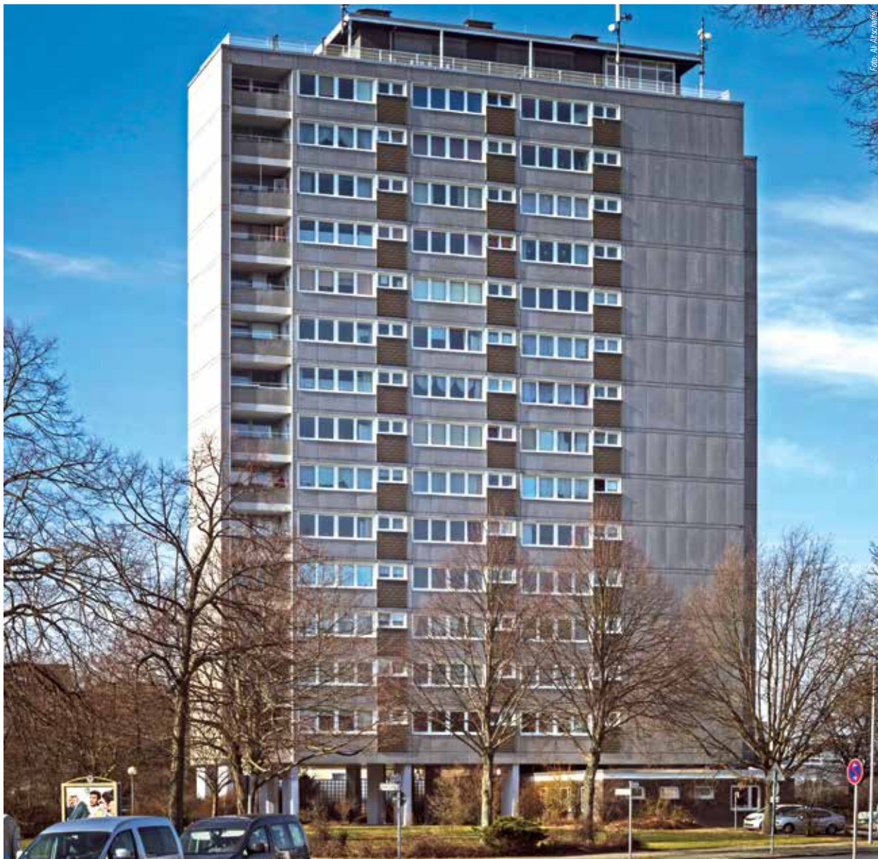
Ansicht von Süden. Die Wandflächen waren ursprünglich mit Kunststeinplatten in unterschiedlichen Tönungen verkleidet. Ein hellgelber Anstrich betonte die kleinen Loggien.
