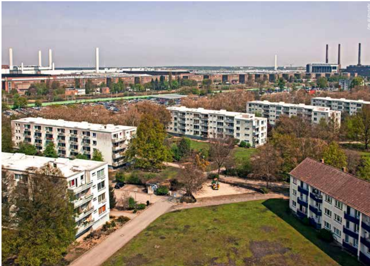
Blick vom Hochhaus Saarstraße auf die Wohnsiedlung Wellekamp. Auf dem dreieckigen Areal erstrecken sich die 4-geschossigen Wohnzeilen in Nord-Süd-Richtung und belassen eine großzügige grüne Insel im Zentrum.
