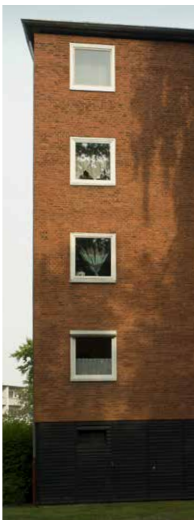
Giebelansicht. Ein leichter Dachüberstand und eine Außenentwässerung sind typisch für die frühen Flachdachbauten
