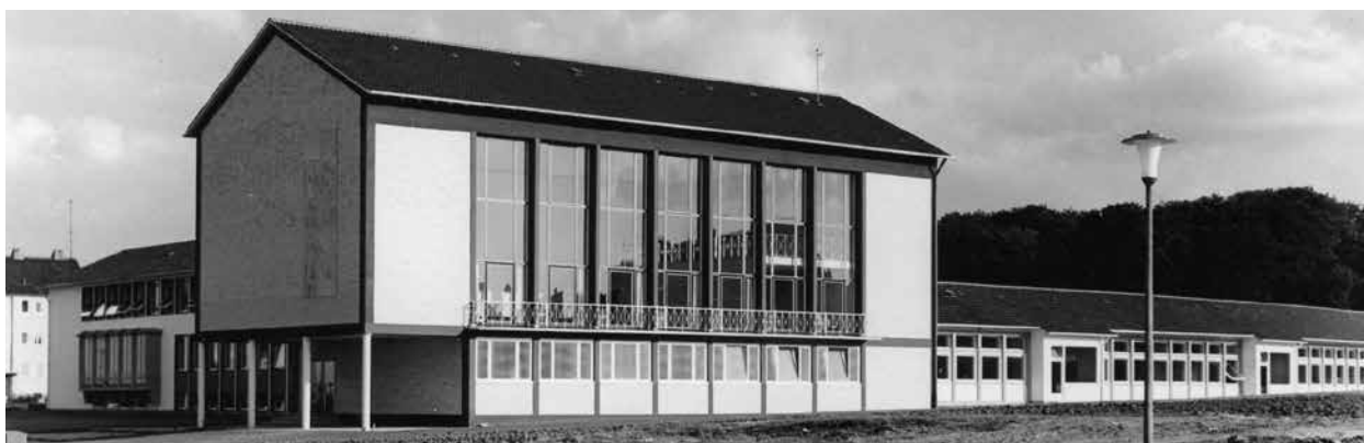
Die modernen Schulanlagen wurden mit Pausenräumen, Hof und Sporthallen ausgestattet. Die unter der Dachkante liegenden Fensterbänder ermöglichen eine beidseitige Belichtung und Belüftung der Klassen.
