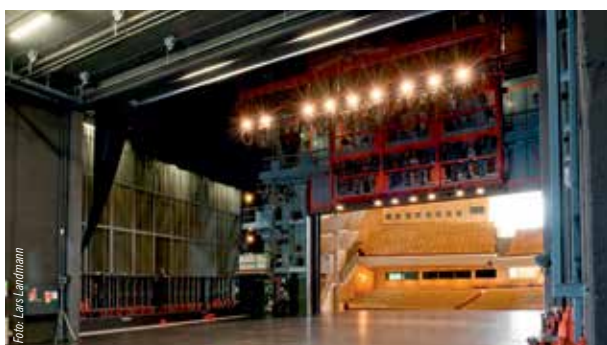
Bühne mit der Portal-Beleuchtungsbrücke. Der Bühnenturm hat eine Höhe von rund 18 Metern
