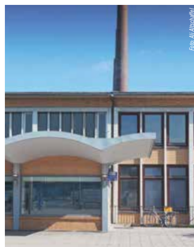
Endpunkt des Schmetterlingsdachs am Empfangsgebäude
