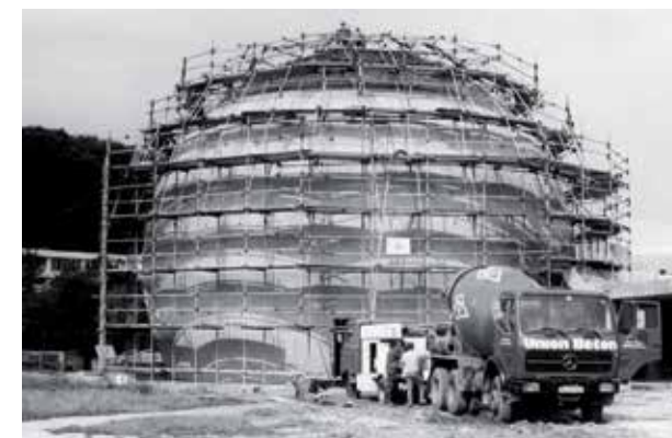
Bauarbeiten für das „Raumflugplanetarium Wolfsburg“, 1983. Aus dem Fotoalbum der VEB Spezialbau Rügen.
