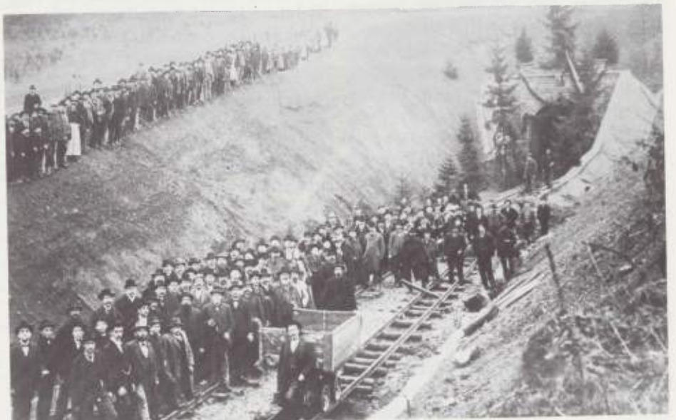
Eröffnung des Tunnels in Hützemert, 1. August 1903.
