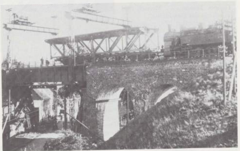
Das Viadukt in der Stadt Drolshagen, noch im Bau (oder Reparatur ca. 1920?).
