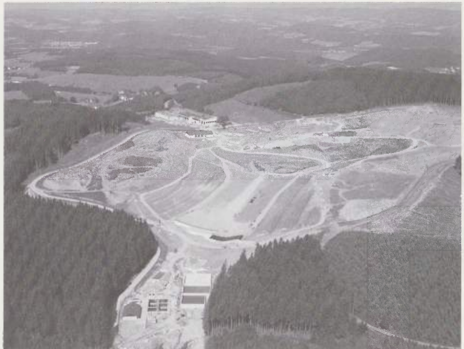
Blick auf die Baustelle im Sommer 1991, nach Westen. Im Vordergrund die Kläranlage, links oben das Kompostwerk.
