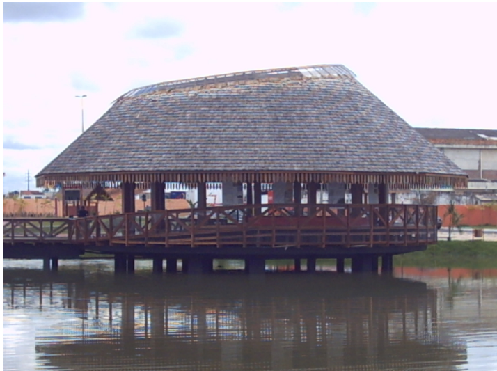
Ilustração 19 O Memorial dos Povos Indígenas, no complexo Ver-O-Rio: a Prefeitura também constrói seu projeto de orla utilizando o conteúdo histórico-cultural local.
