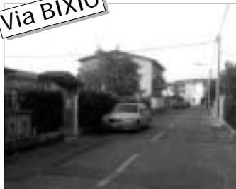
RIFACIMENTO IMPIANTO ILLUMINAZIONE
