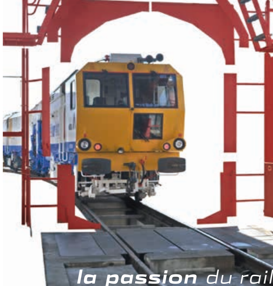
Überprüfung des Lichtraumprofils
