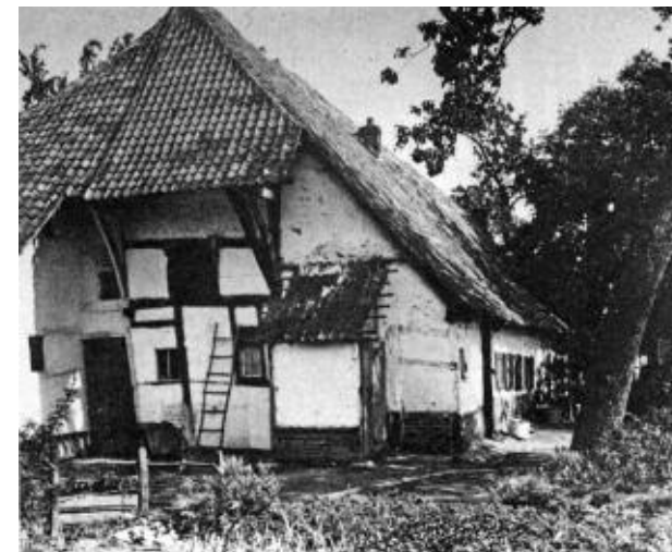
„Niederrheinisches Hallenhaus“ auf der Lookhütte 1910.
