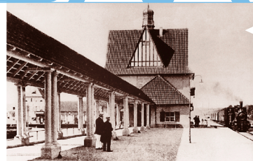
Mittelpunkt von Bad Saarow bildet der im Jahre 1911 von dem Architekten Emil Kopp entworfene Bahnhof mit seinen ausladenden Kolonnaden.
