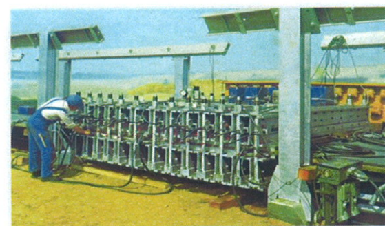
Bild 1. Gurtverbindung mit einer NILOS-Vulkanisierpresse im Braunkohletagebau
