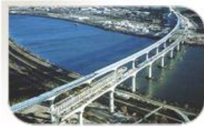
Viaduc d'Avignon, France
