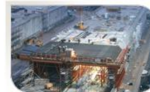
Tunnel de Rostock, Allemagne
