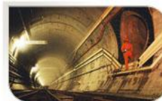
Tunnel sous la Manche, France/Angleterre
