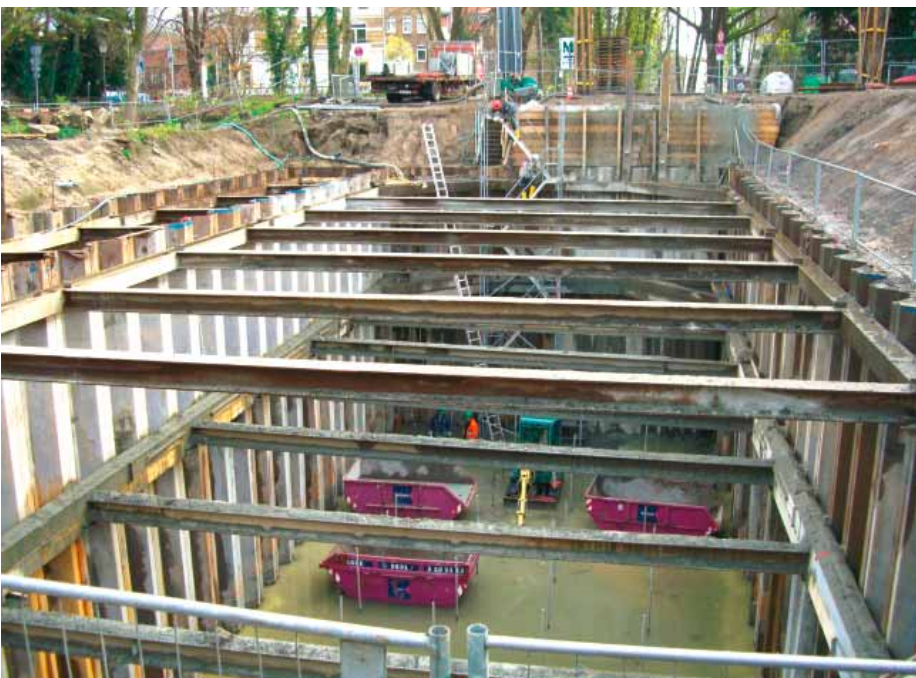
Zielbaugrube Z1 nach dem Lenzen
