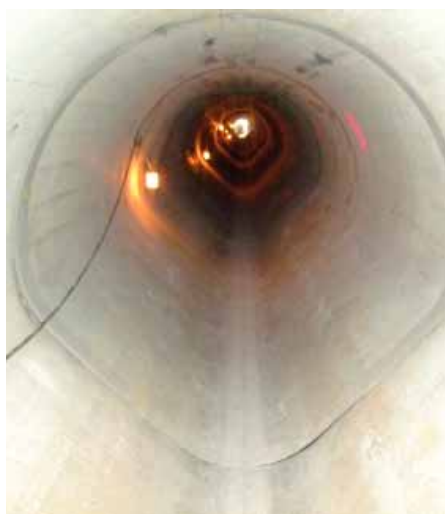
Blick in den vorgetriebenen Rohrstrang S1-Z1
