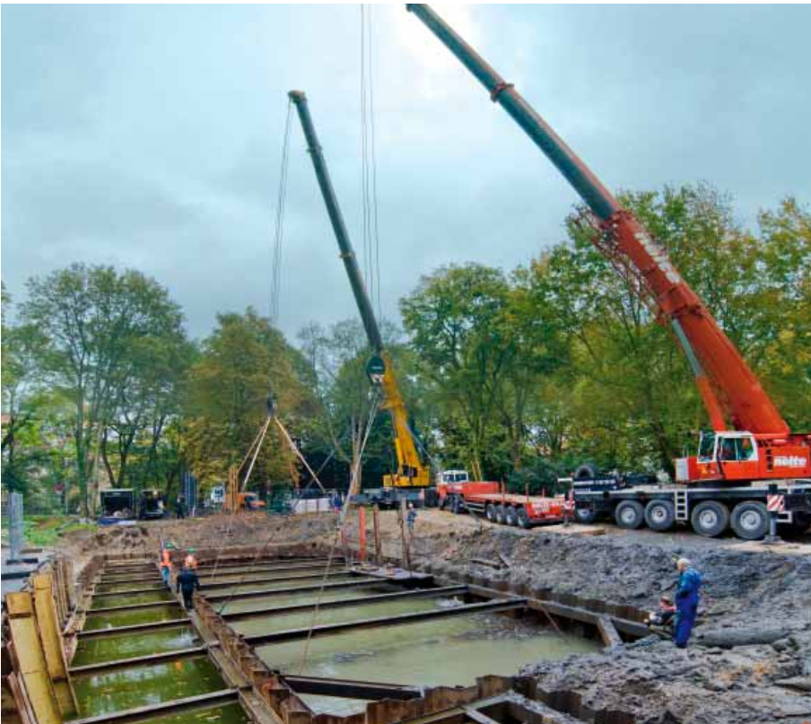
Herstellung der Zielbaugrube Z1
