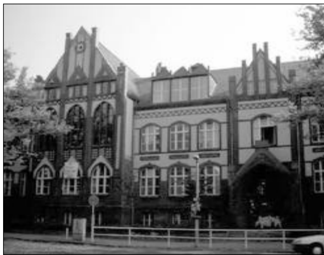
Die Schillerschule wurde mit Millionen saniert. Fotos: Dittmann
