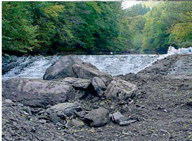
◀ Wasserhaltung mit sogenannten "Bigbags" ▼ Setzen der ersten Riegel
