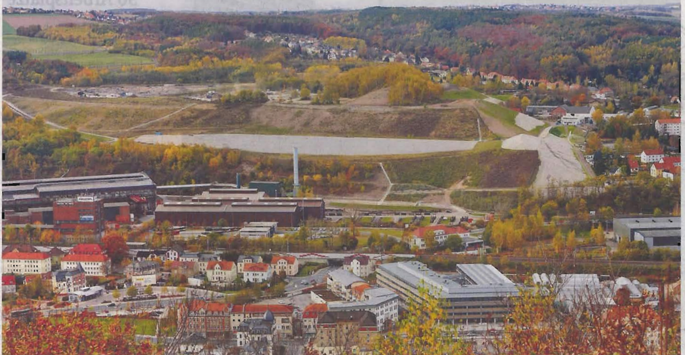
Vom Windberg aus hat man einen guten Überblick über das Sanierungsgebiet Saugrund. Die weiße Fläche ist die ehemalige Hüttengrundhalde, dahinter die Paul-Berndt-Halde. Rechts der hell gefärbte Hang ist die bereits sanierte Kettenberghalde.
