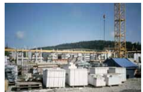
Baustelle Grundschule Mitte
