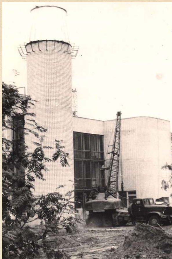
1984г. Строительство СЮТ
