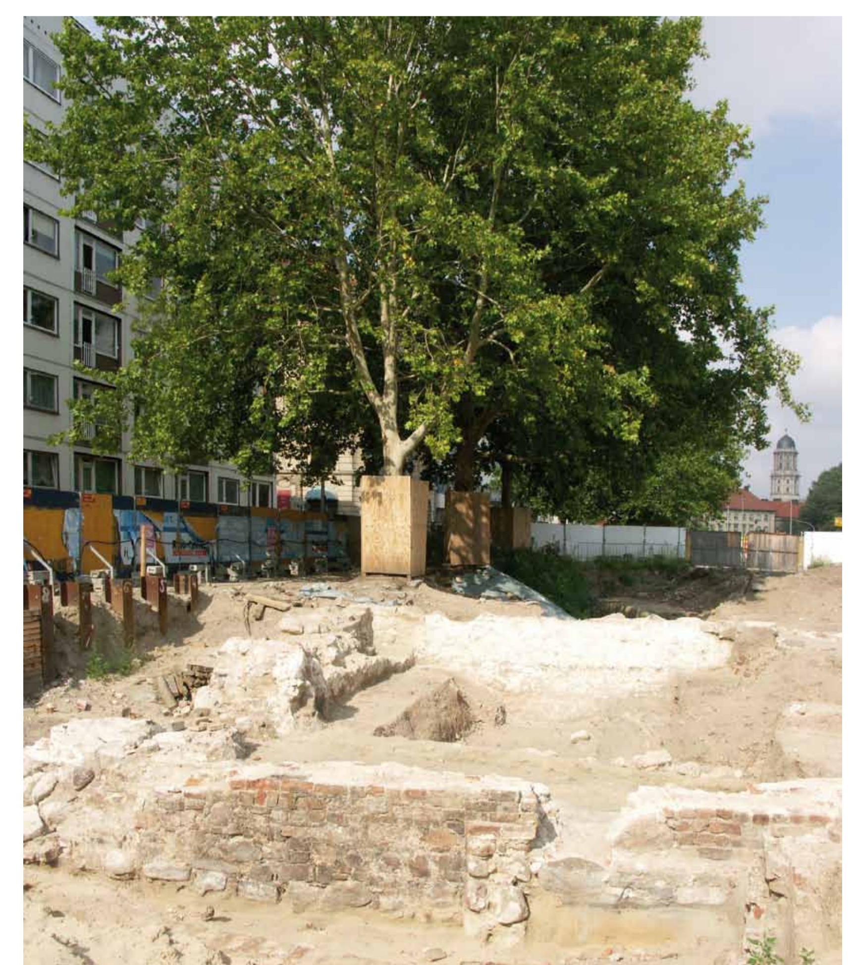
Die Fundamente der Cöllnischen Lateinschule sind ebenso in das städtebauliche Konzept zu integrieren wie die Wohnbebauung der DDR-Zeit an der Scharrenstraße.
