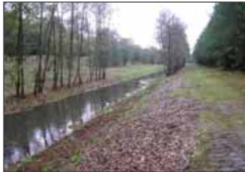
Schotterung von Sohle, Ufer und Böschung
