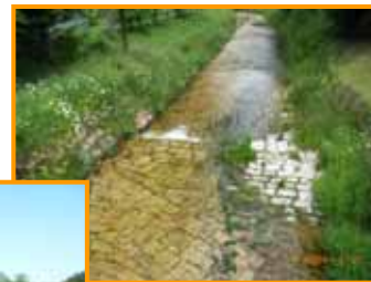
Sohlverbau an der Großen Bockau
