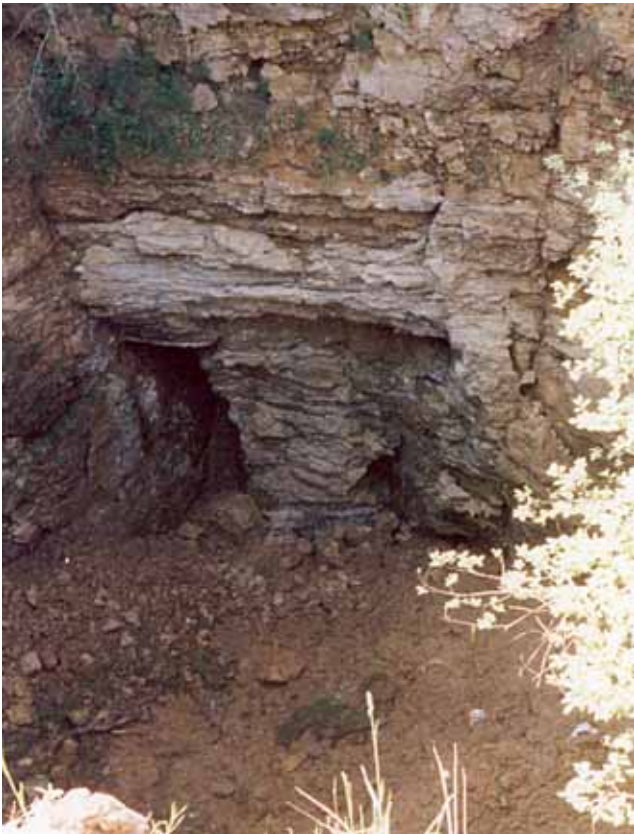
Abb. 28: Durch Subrosion im Mittleren Muschelkalk und Verkarstung im Oberen Muschelkalk brach eine 70 m tiefe Höhle ein. Beim Einsturz des Höhlendaches, das aus Schichten des Oberen Muschelkalk (mo2, mo3) besteht, wurde der Hohlraum auf ca. 38 m Tiefe aufgefüllt. Sie stellt ein relativ junges Stadium der Dolinenentwicklung dar (Doline Roßhag, Löffingen, LK Breisgau-Hochschwarzwald, lfd. Nr. 49).
