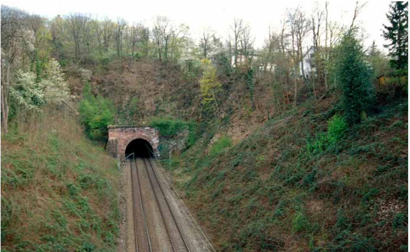
Abb. 91: Loretotunnel, Freiburg im Breisgau (Nr. 3)
