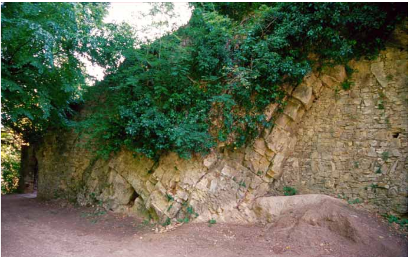
Abb. 169: Doggerprofil an der Nordmauer der Oberburg (Ruine Rötteln), Lörrach (Nr. 20)
