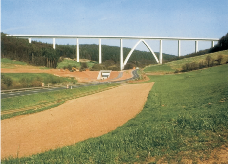
Ansicht der Brücke
