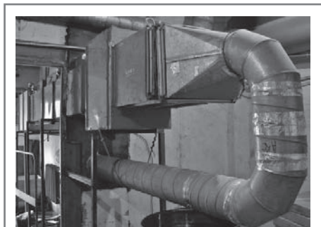
Рис.4. Газоконвертор для промышленной очистки воздуха и газов от вредных, веществ органической природы и для обеззараживания приточного воздуха.
