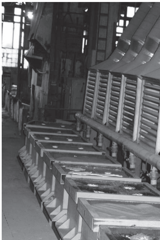
Рис.2. Вытяжная вентиляция при заливке
