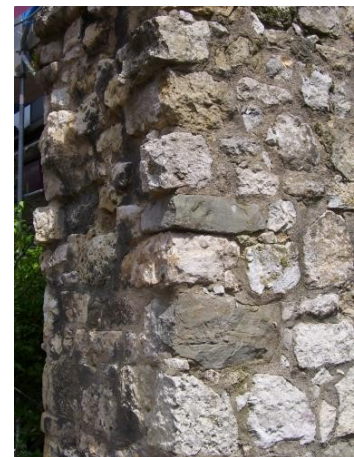
Stadtmauer an der VHS
