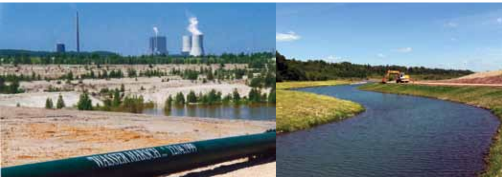
Einbindung der Verflutanbindung vom Hainer See in die Pleiße, 2010 Flutungsleitung zum Kahnsdorfer See, 1999 Baumaßnahmen zur Anbindung des Hainer Sees an die Vorflut, 2010
