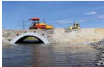
Bau der Vorflutabbindung vom Hainer See zur Pleiße, 2010
