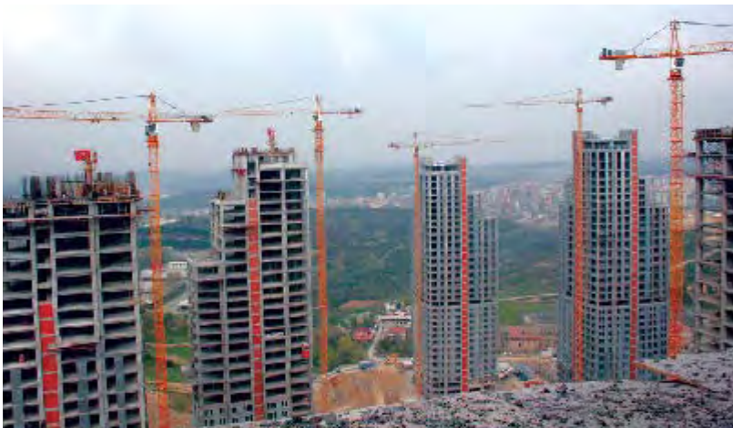
土耳其承包商Tasyapi公司正在使用10台利勃海尔132 EC-H型塔式起重机完成一个为期36个月的合同,在伊斯坦布尔建造包括10座大楼的Mashattan项目。该建筑最高高度为140m被认为是土耳其目前最高的住宅楼项目。
