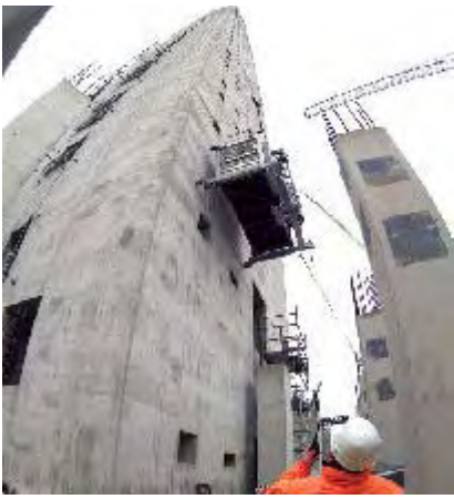
Steinweg-Böcker 公司的新型 Giantlift系列叉车可以配置单或双货架,可以将最大3.2t重的货物提升到最高400m的高度。
