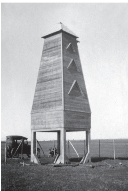
Un pipistrellai utilizzato durante la bonifica dell'Agro Pontino
