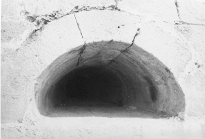
Foto 6: Orpesa, Castelló. Torre del Rei. Detalle de la bocana abombada de una de las caponeras de la Torre. Obsérvese la perfección técnica de su trazado a base de cinco piezas arqueadas de las cuales una sirve de clave.
