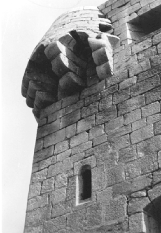
Foto 8: Oropesa, Castelló. Torre del Rei. Garitón del SO. Puede observarse perfectamente el bello trazado de las robustas ménsulas o canes. En ella y en su parte lateral derecha dos orificios rectangulares que responden a la pequeña tronera y correspondiente mirilla. Más a la derecha, tronera adintelada de artillería. Bajo, pequeño tragaluz para dar visibilidad a las escalera que discurre por el corazón del muro.
