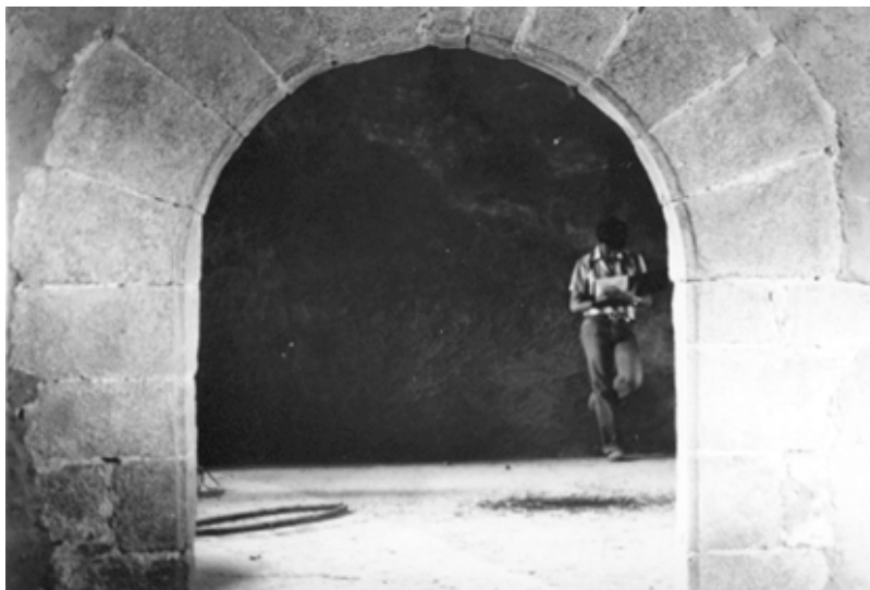
Foto 7: Orpesa, Castelló. Torre del Rei. Aspecto exterior del arco-portal que comunica las dos salas existentes en la planta principal. Parece ser que esta arcada no corresponde originariamente a la obra de la Torre por cuanto está ampliada en sus dimensiones de luz, quedando ligeramente festoneada. El labrado de la piedra corresponde a dos herramientas distintas –"picola" y "punxó"–.
