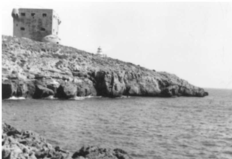
Foto 4: Oropesa, Castelló. Torre del Rei. Vista general de la Torre sobre el acantilado del Cabo de Oropesa. Al fondo, el faro. Esta torre fue levantada en 1534 por En Joan de Cervelló, señor del territorio, para que sirviera de vigilancia y defensa de la Costa valenciana.
