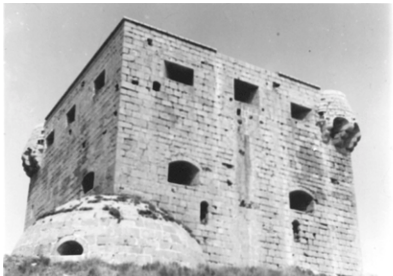
Foto 1: Orpesa, Castelló. Torre del Rei. Puede observarse la grandiosidad de la obra de la Torre con sus dos plantas dispuestas para se artillada como demuestran claramente sus líneas de troneras. De ellas, unas con bocana abombada, otras de forma adintelada. En primer término robusta caponera o casamata y en lo alto de los ángulos laterales, los bellos garitones
