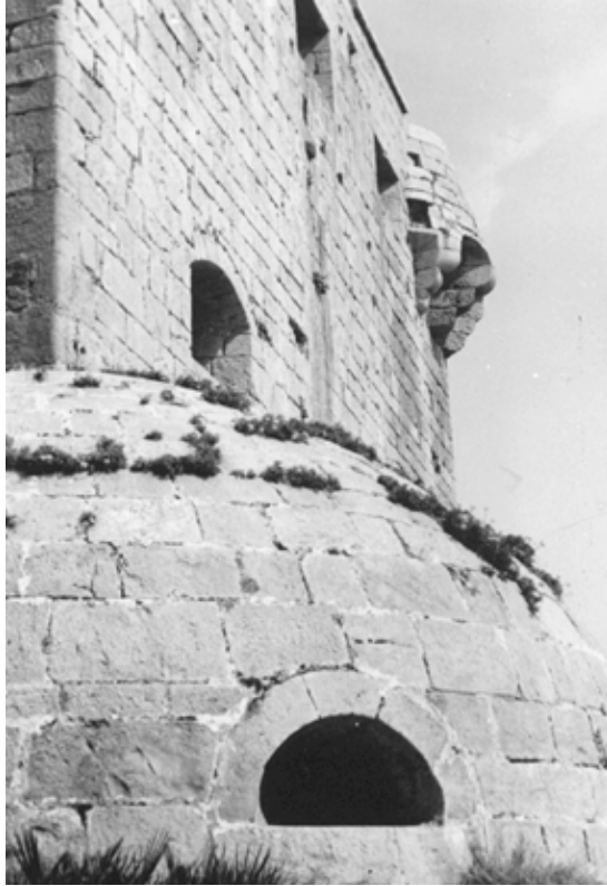
Foto 9: Orpesa, Castelló. Torre del Rei. Bello conjunto defensivo de la Torre compuesto de caponera, tronera y garitón. Elementos fundamentales y característicos de esta colosal obra defensiva de Costa. La caponera y el garitón barrían tangencialmente de forma inexorable los distintos paramentos de la misma.
